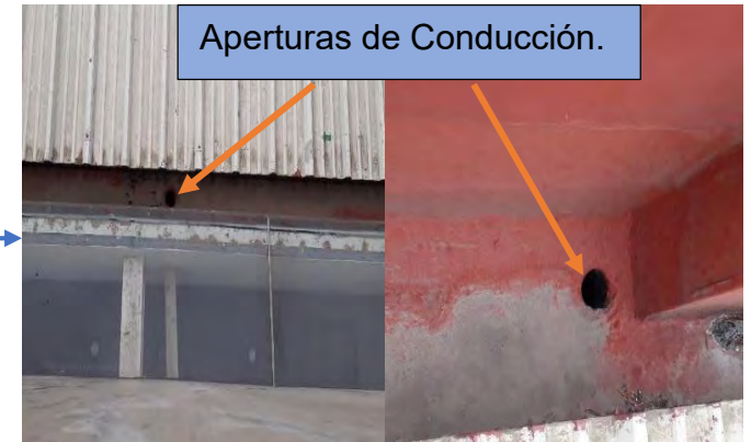
Figura 10.- Aperturas de la azotea para la conducción del agua de lluvia.
