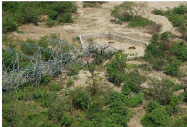
**Figura 7.4** Falla por arrancamiento de los cimientos de la torre (IIUNAM, 2015)
