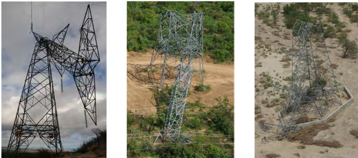
Figura 7.2 Falla por flexión en el cuerpo de la torre (IIUNAM, 2015)
