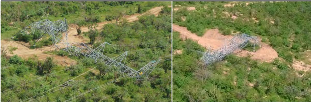
**Figura 7.3** Falla por flexión en la base de la torre (IIUNAM, 2015)
