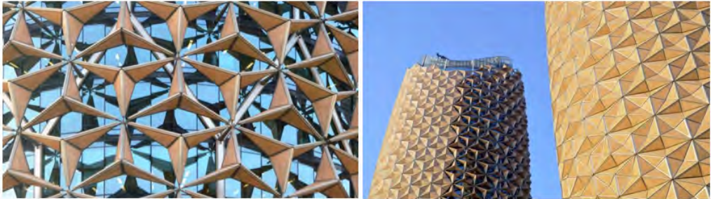
Figura 12.0. Fachada de las Torres Al Bahar. Extraído de “Los 10 edificios más inteligentes del mundo en 25 fotos” de I. Valdés. El País . Recuperado de https://elpais.com/elpais/2017/03/28/fotorrelato/1490700079_006213.html#f
