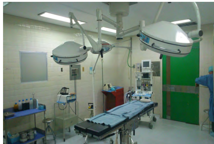
Fotografía 14: Sala de expulsión en el área de Tococirugía.
