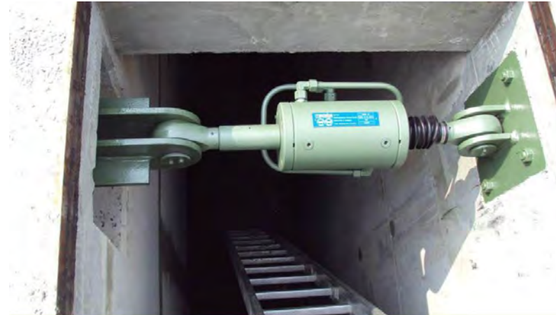
[Imagen 71] Disipador viscoso marca Reston PSD.
