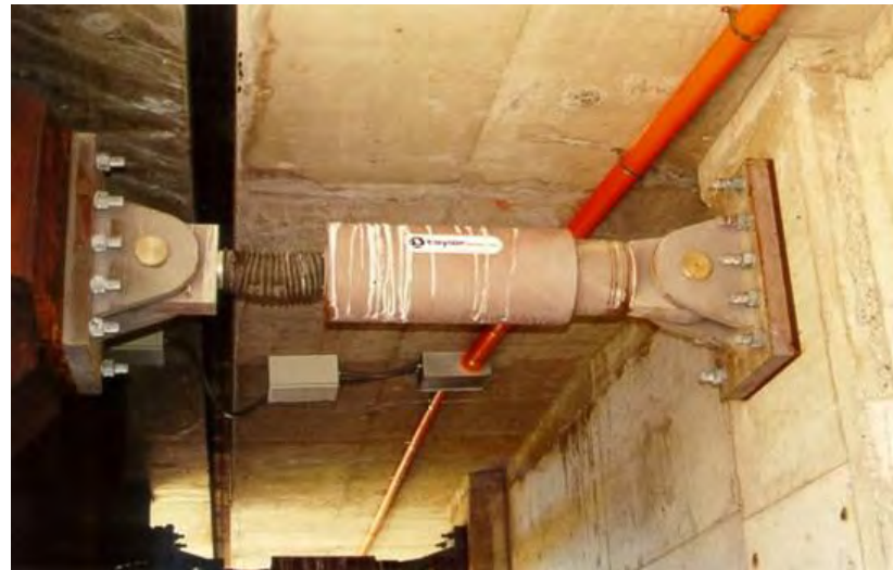
[Imagen 72] Disipador viscoso marca Taylor.
