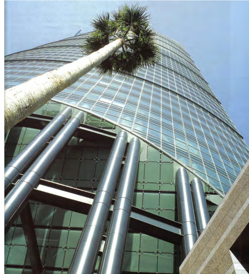
[Imagen 29] Fachada Principal se aprecia la ligera curvatura.
