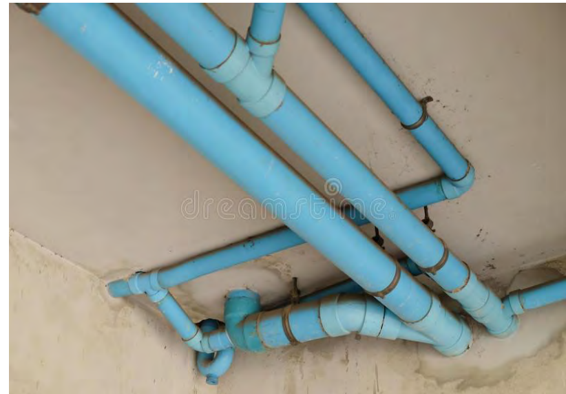
[Imagen 76] Instalación de PVC Sanitario
