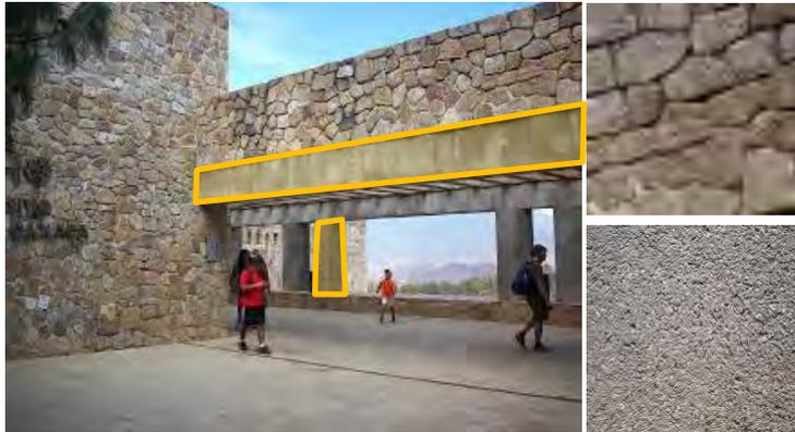
Fig. 50. Vista del acabado y el sistema constructivo que levanta al edificio, siendo la piedra y el concreto los materiales predominantes.
