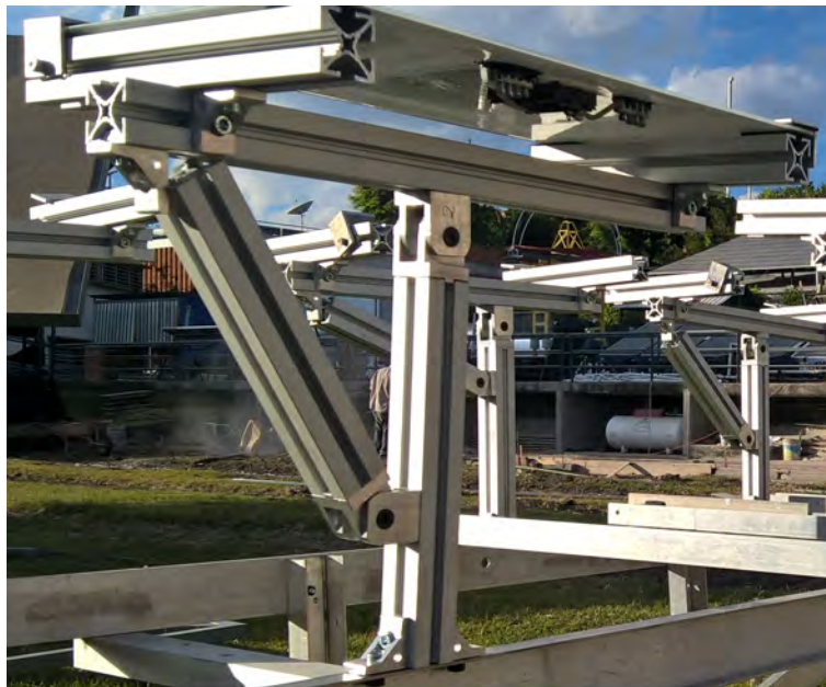
Fig. 3.20. Estructura a base de rotulas la cual permite inclinar las celdas a cualquier ángulo.
