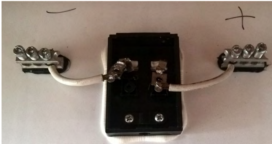
Fig. 4.3. Modificación en las terminales de conexión de las celdas.
