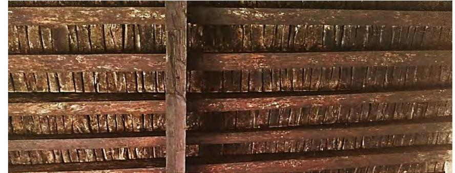
Ilustración 16. Tipos de Cubierta que se encuentran en la hacienda Encarnación de Guzmán, en la imagen superior se puede observar el terrado y parte de los carrizos de ocotillo que sostienen el terrado, en las calpanerías. En la imagen inferior el tablado de madera que se encuentra en la casa grande. Fotografías. Ing. Bernardo Reyes Zúñiga – Arq. Sergio Noe Torres Luna. Octubre – Diciembre 2016.
