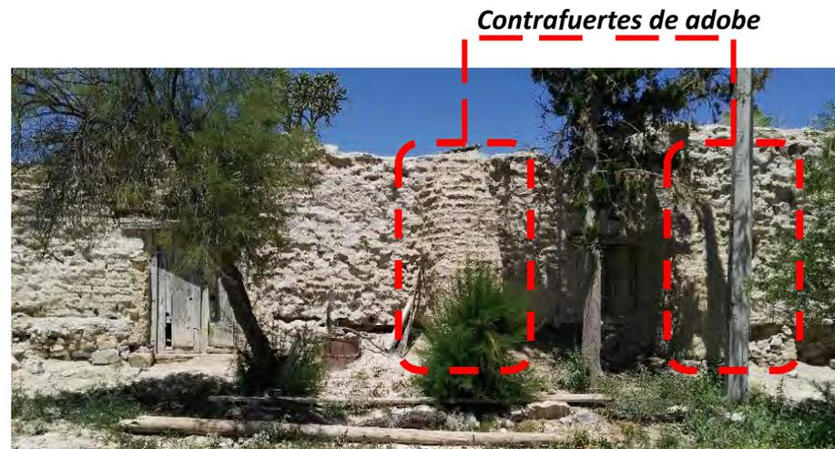
Ilustración 10. Sección de la fachada de las calpanerías, donde se marcan con rojo parte de los contrafuertes que se encuentran en la construcción. Fotografía: Arq. Sergio Torres Luna – Ing. Bernardo Reyes Zúñiga. Octubre 2016
