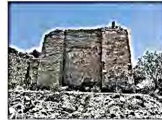
DETALLE DE LA CONSOLIDACIÓN DE MURO DE ADOBE A BASE DE RAJILADO EN JUNTAS Y APLICACIÓN DE CAL CON BABA DE NOPAL Y LA CONSOLIDACIÓN DE CONTRAFUORTE DE PIEDRA Y ADOBE A BASE DE SUSTITUCIÓN DE PIEZAS EN MAL ESTADO Y DISGREGACIÓN DEL MATERIAL.
