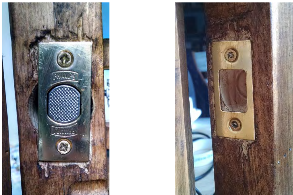
Figura 4.21 Colocación de la barra metálica de la cerradura. (Fuente: Elaboración propia)
