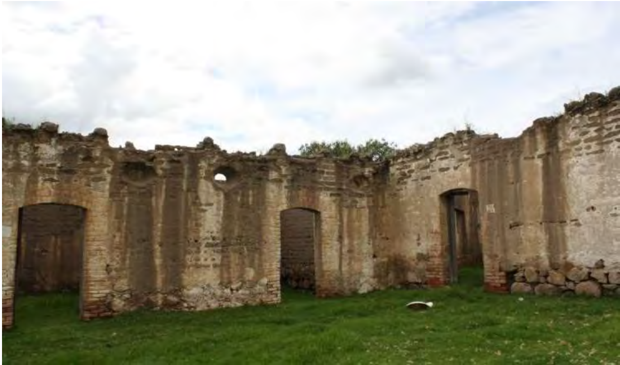
Figura 44 Fotografía de la fachada de las Calpanerías, 2016.
