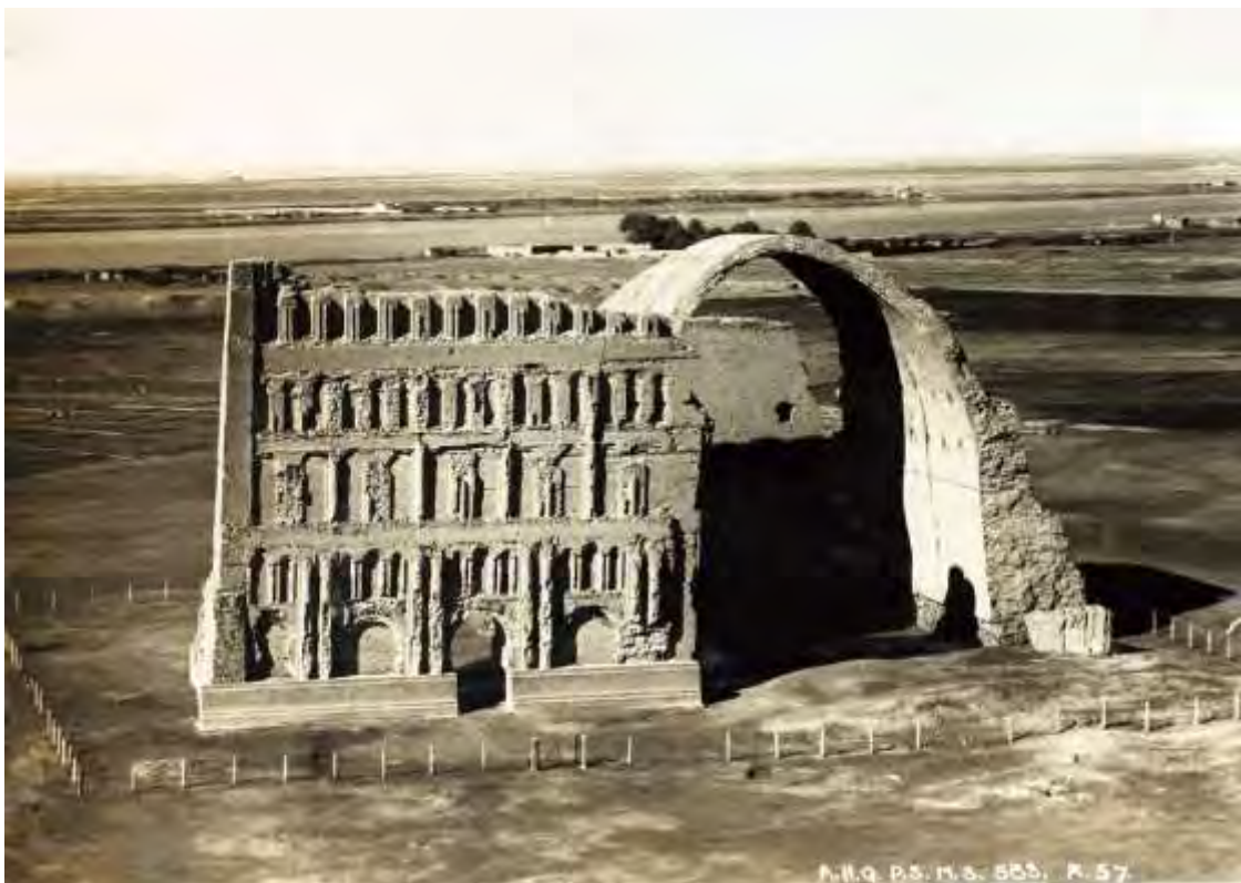
Figura 12 Ctesiphon Arc, el arco sin soporte más grande del mundo (Newman, 2012).
