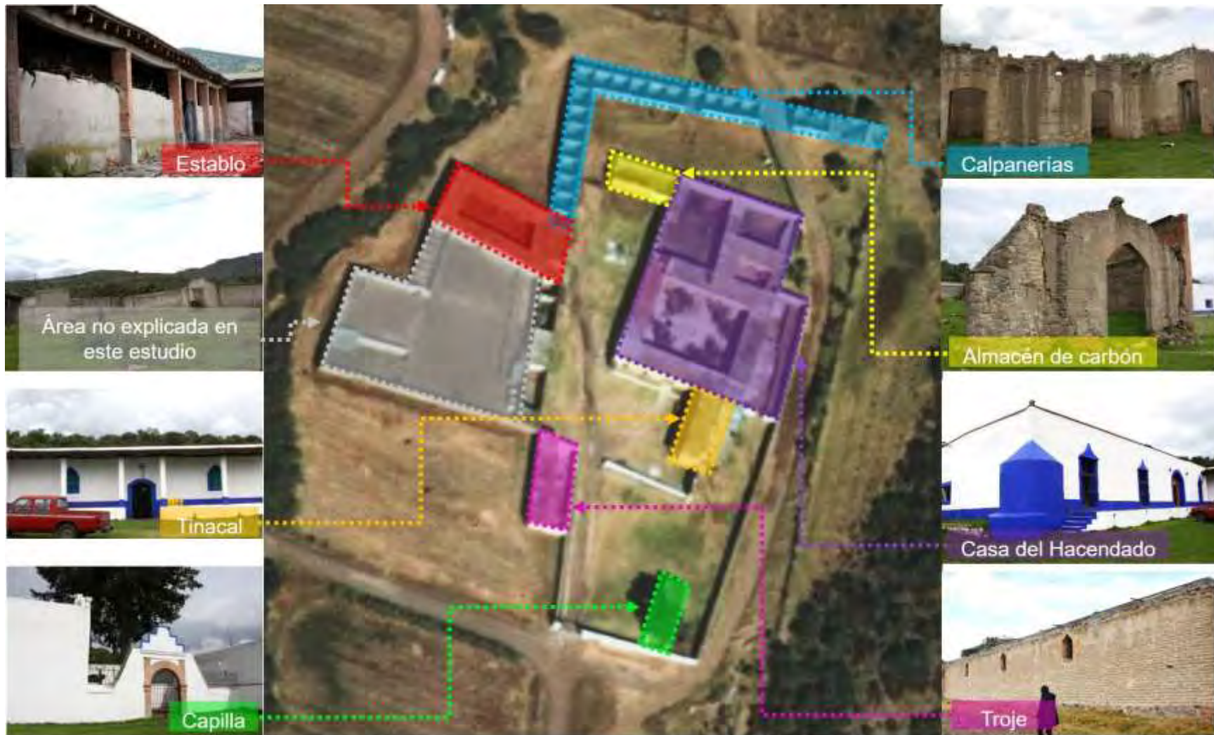
Figura 50 Vista aérea del conjunto y ubicación de los espacios de la hacienda, 2018.
