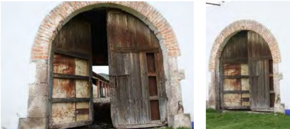
Figura 48 Fotografía del acceso principal del Establo, 2016.
