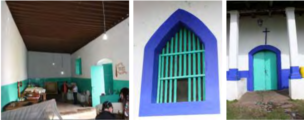
Figura 38 Fotografía del acceso e interior del Tinacal, 2016.
