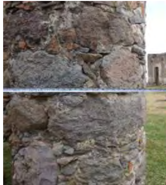
Muro de piedra
