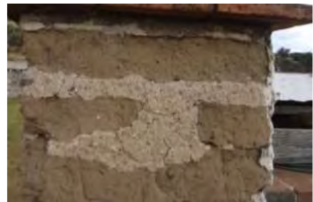
Muro de adobe
