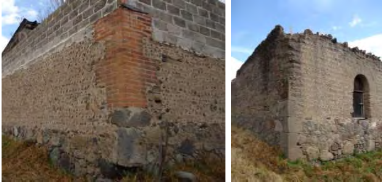
Figura 20 Refuerzo de muro en esquinas de ladrillo y piedra, Hacienda San Diego Xochuca.
