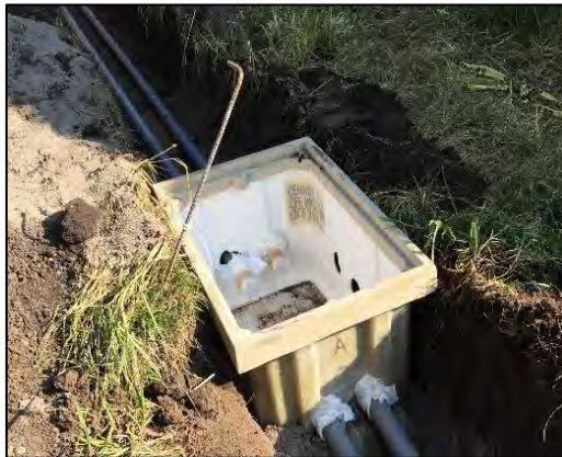
Figura 6.6 Instalación de un registro y tubería
