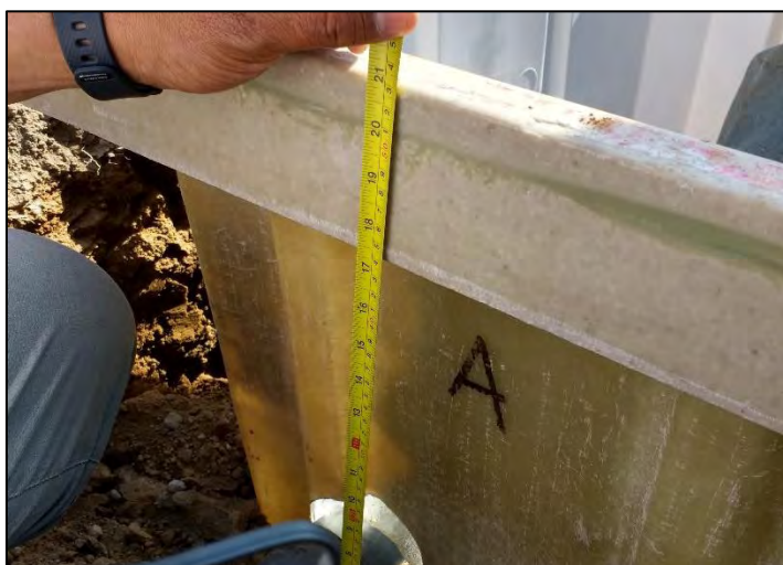
Figura 6.4 Profundidad establecida en zanjas
