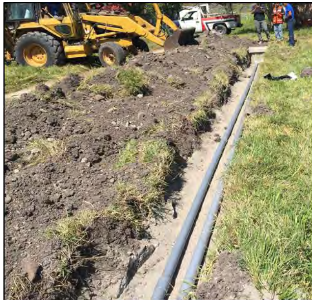
Figura 6.3 Instalación de tubería principal en una zanja
