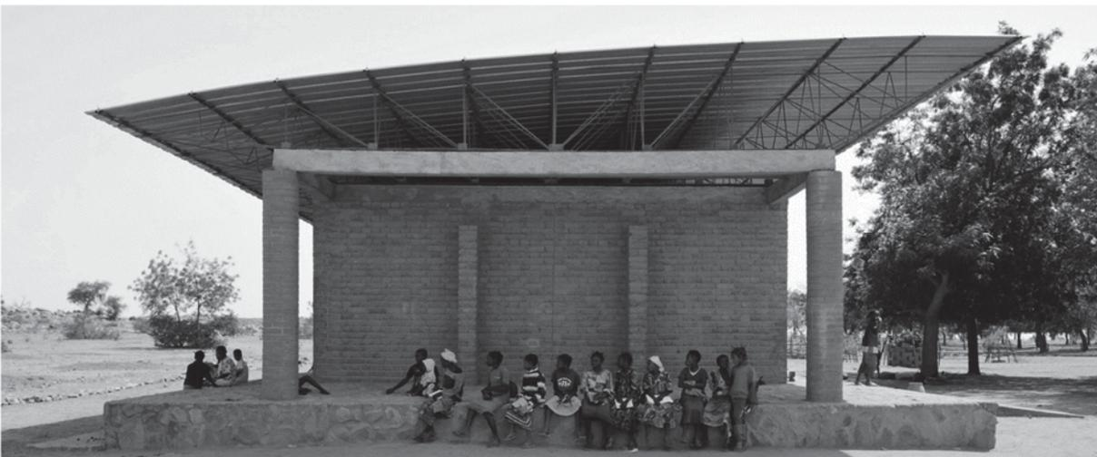
Fachada oeste, se aprecia la doble cubierta y el uso de los bloques de tierra.
