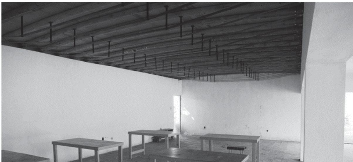
Cubierta en área de reuniones hecha con viguetas de bambú y tensores de acero que valió el apoyo del Conacyt
