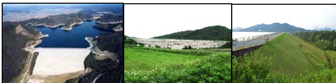
Figura 2.1- Presa Kotani, Gongen y Heiso antes de la instalación de paneles
