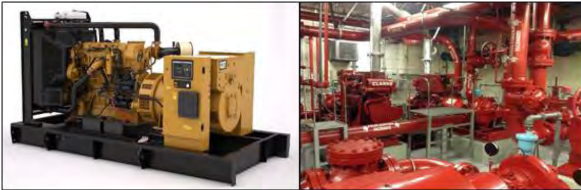
Figura 2.6 A la izquierda se aprecia una planta de emergencia Diesel modelo Electrógeno Diesel C18 ACERT, imagen tomada de productos Caterpillar. A la derecha motor Diesel empleado en sistema auxiliar de arranque contra incendio de la marca CLARK. Instalación del sistema de protección contra incendios, edificio Torre Mayor, Ciudad de México.
