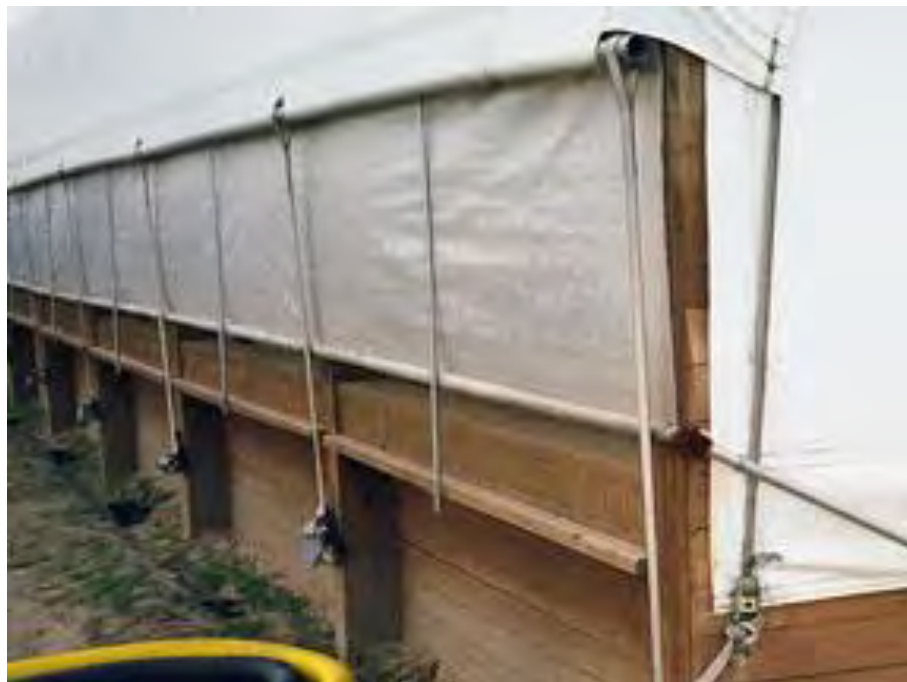
Figura 1.33. Cortinas laterales, para un mejor control de la ventilación y temperatura interna del galpón. Tomado de: leopold.iastate.edu
