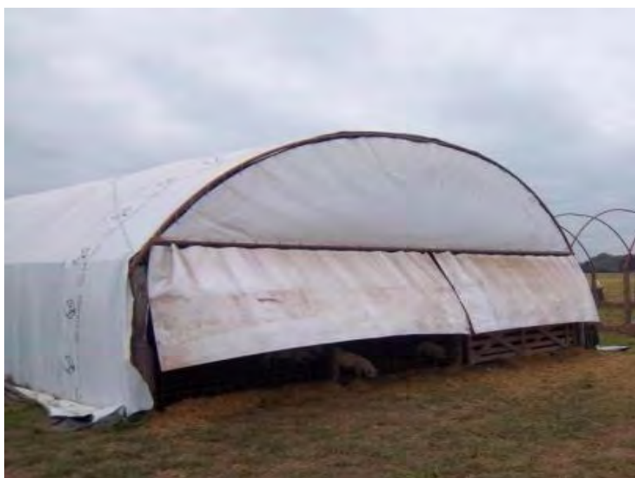
Figura 1.36. Cortinas para el control de ventilación y la temperatura al interior del galpón. :
