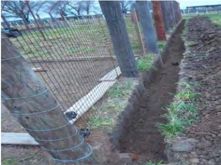
Figura 1.34. Zanja lateral Tomada de: inta.gob.ar
