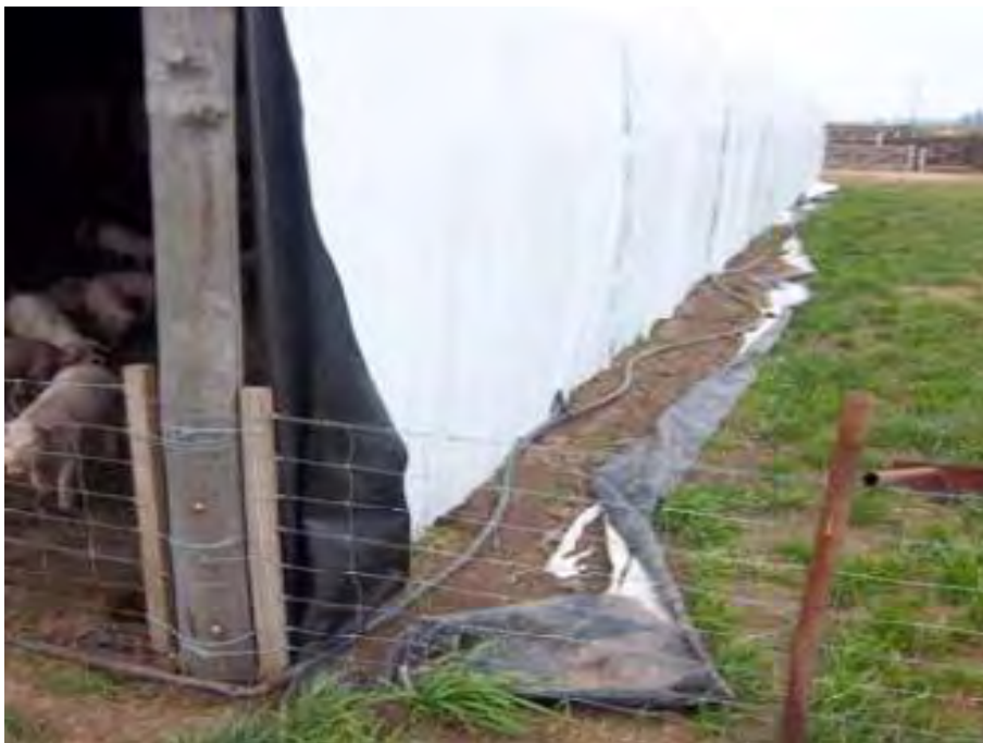
Figura 1.35. Lona atrapada con tierra, dentro de la zanja lateral. Tomada de: inta.gob.ar
