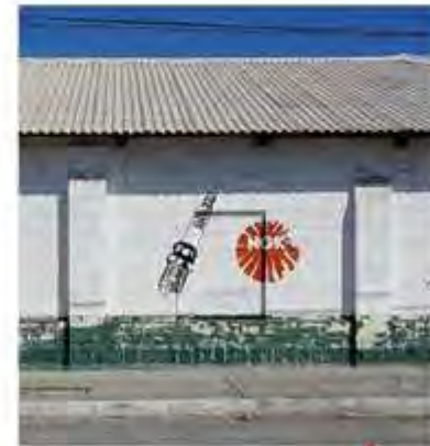
Ventanas tapiadas con ladrillo.
