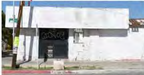
Abandono y vandalismo.
