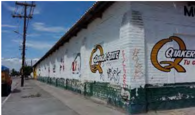
Foto 18. Puerta y ventanas tapiadas. Se aprecia fácilmente el lugar donde antes existió una ventana o una puerta, ya que no se tenía la intención de eliminar el vestigio.
