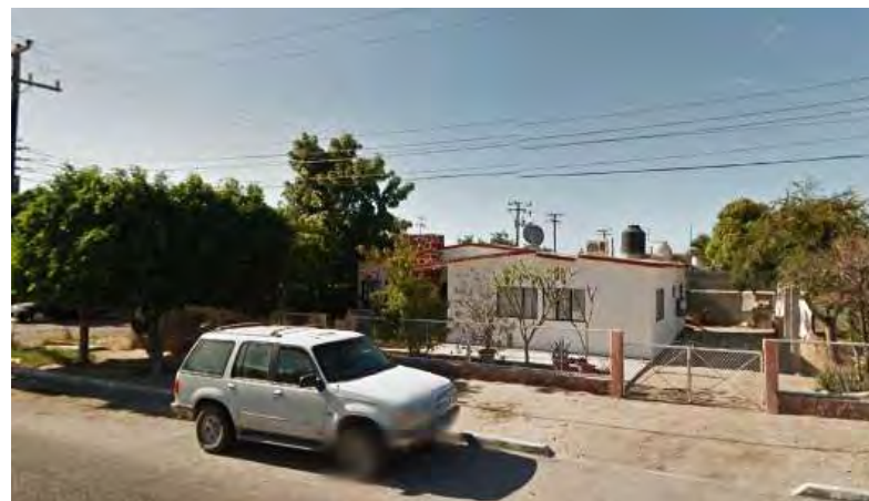
Foto 8. Casa habitación en contra esquina de Josefa Ortiz y Antonio Navarro. Tomada de GM
