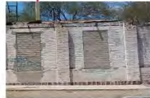
Tapiado de ventanas con block.
