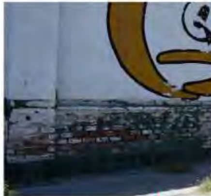
Perdida de juntas por erosión y salinidad ascendente.
