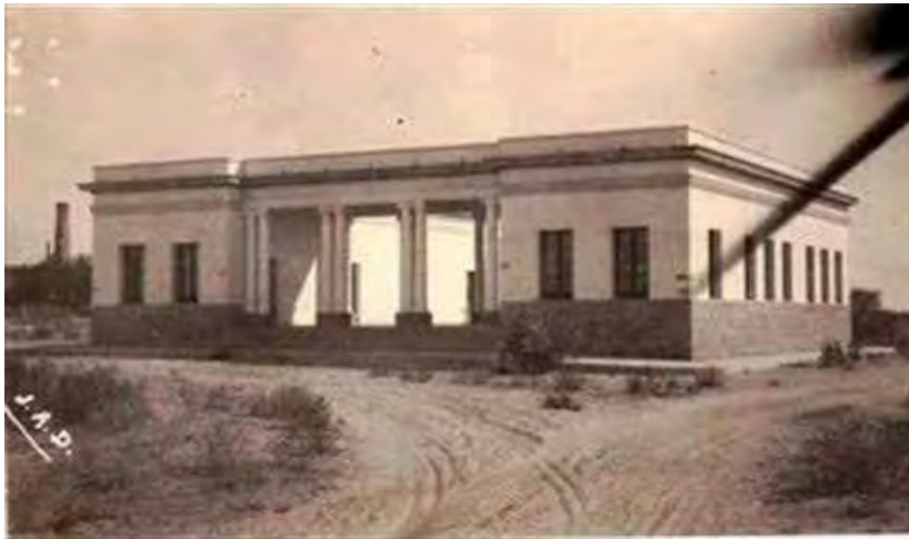
Foto 10. Escuela de La Tenería de La Paz, la número 48, al fondo la chimenea de La Tenería. Revisada en el AHPLM
