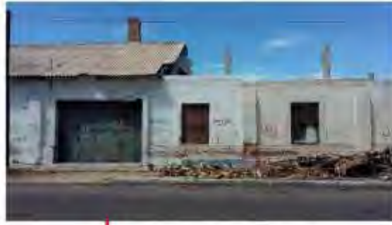
Colapso de sistemas de cubiertas
