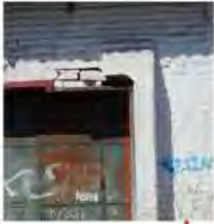
Corte de pilastra para la apertura de puerta.
