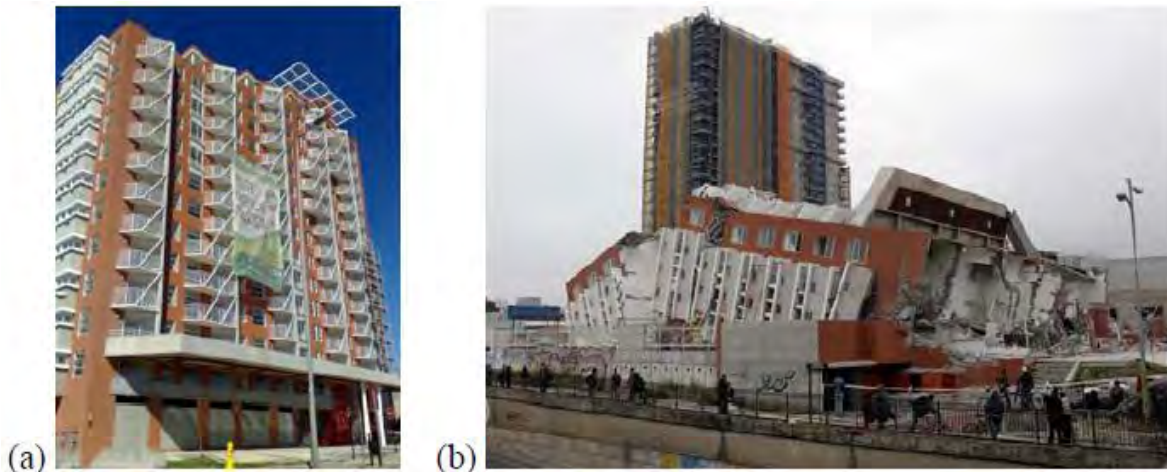
Figura 1.3 Fotos del edificio Alto Río, ubicado en Concepción, Chile: (a) antes del terremoto y (b) después del terremoto de febrero de 2010
