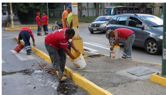
Foto: Instalación de servicios municipales https://casas.trovit.com.mx/condominio-horizontal-
