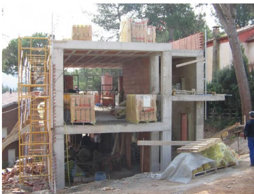
Foto: Estructura de concreto en vivienda
