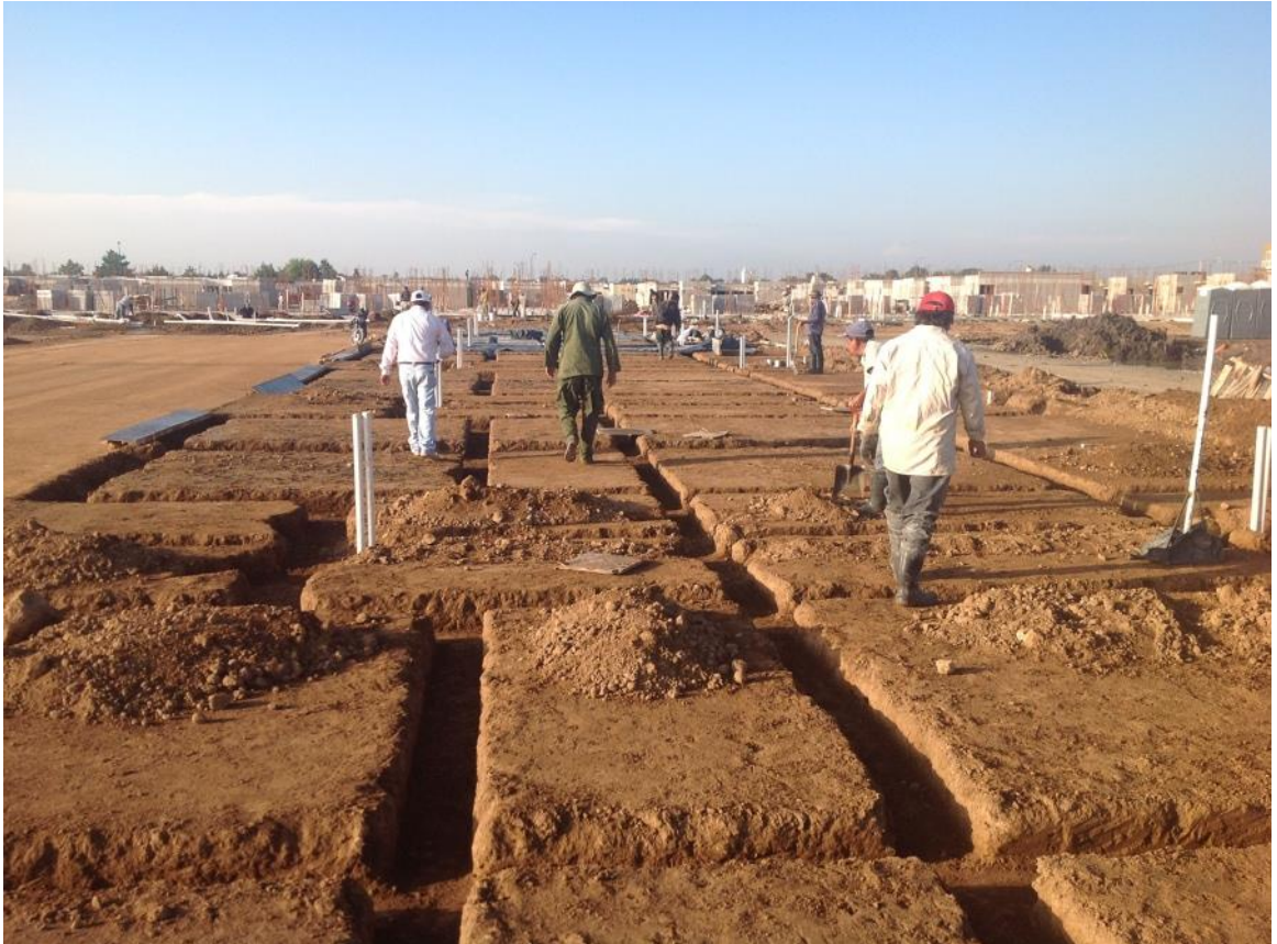
Foto: Diseño de excavaciones para cimentación de viviendas
