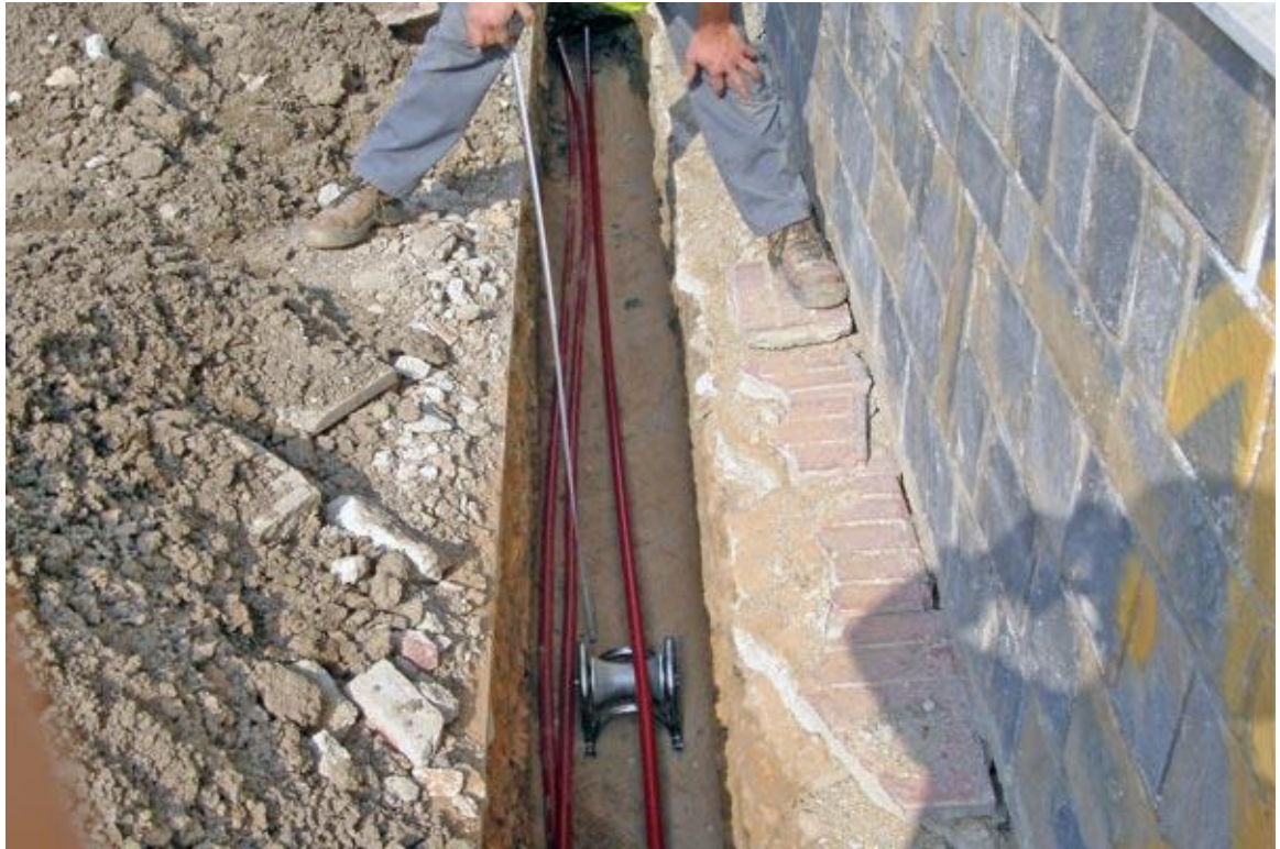
Foto: Instalación de cables ocultos http://www.mndelgolfo.com/
