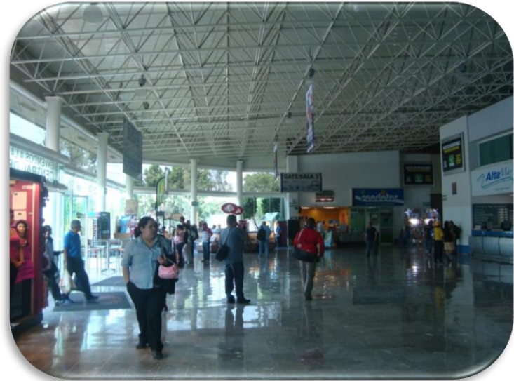
Sistema Constructivo en vestíbulo de Terminal Sur
