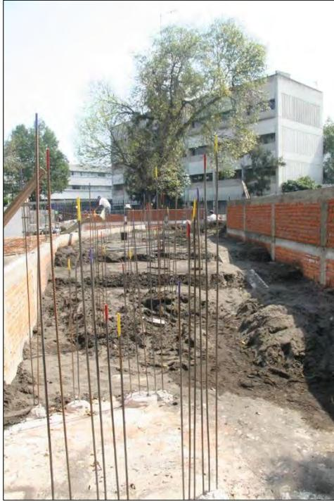
**Figura 4.2.** Colocación de arena para la conformación de la topografía.
