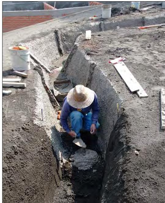
**Figura 4.3.** Colocación de concreto para definir la topografía final.
