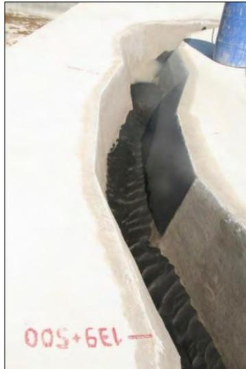
**Figura 4.11.** Depósito de sedimento fino entre secciones 139+500 a 140+000, arena negra.
