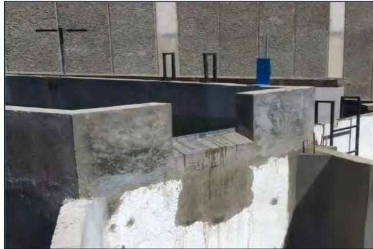
*Figura 4.4. Vertedor de aforo.*
