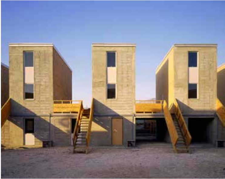
[5].Vista desde el exterior de la Quinta Monroy/Elemental, case finalizado el proceso de obra.
