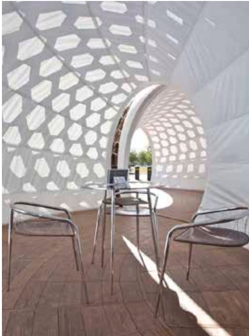
[63].Foto del interior del pabellón, se observa la tela a prueba de agua.
