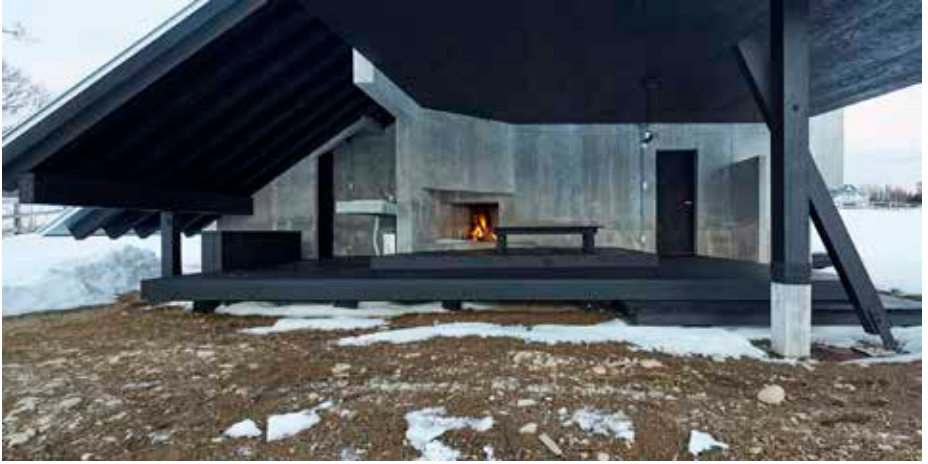
[28].Vista desde el área de cocina y el área de estar exterior.
