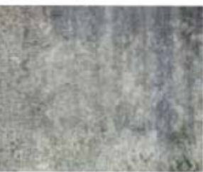
Muros de Concreto, acabado aparente.
