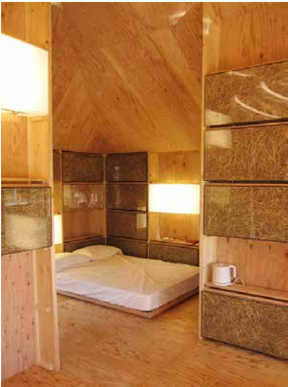
[12].Imagen del interior, se aprecia el dormitorio, y que hacia el interior mediante “contenedores” se guarda la vegetación natural ya seca, que ayudará a mantener el calor.
