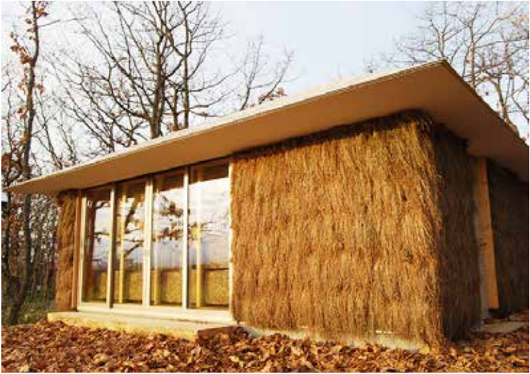
[11].Imagen del exterior, se aprecian los muros a base de hierbas compactadas.
