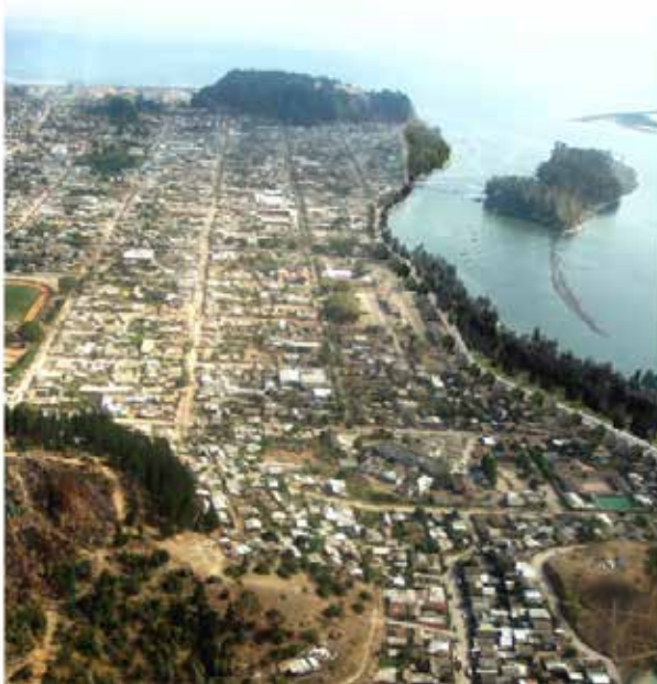
[9].Imagen que muestra cómo será la barrera natural, en las orillas del río para proteger a los pobladores.
