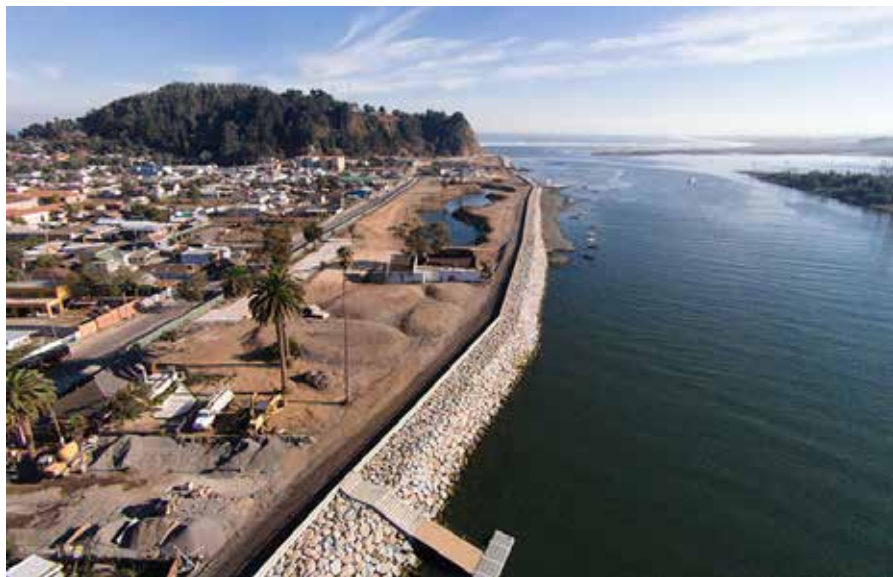
[10].Imagen del proceso de obra de la barrera natural.
