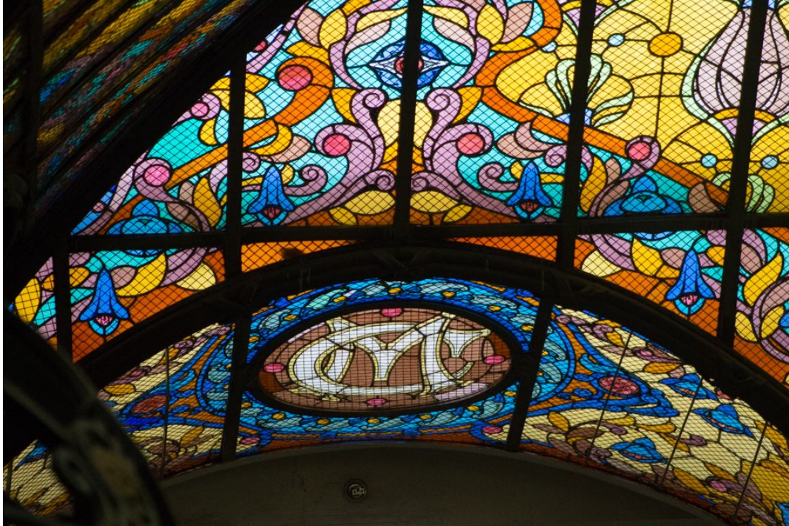
Imagen 3.44 DETALLE DEL TRAGALUZ DEL GRAN HOTEL CIUDAD DE MÉXICO 2016 Se pueden ver las letras “CM” que significan “Centro Mercantil”
