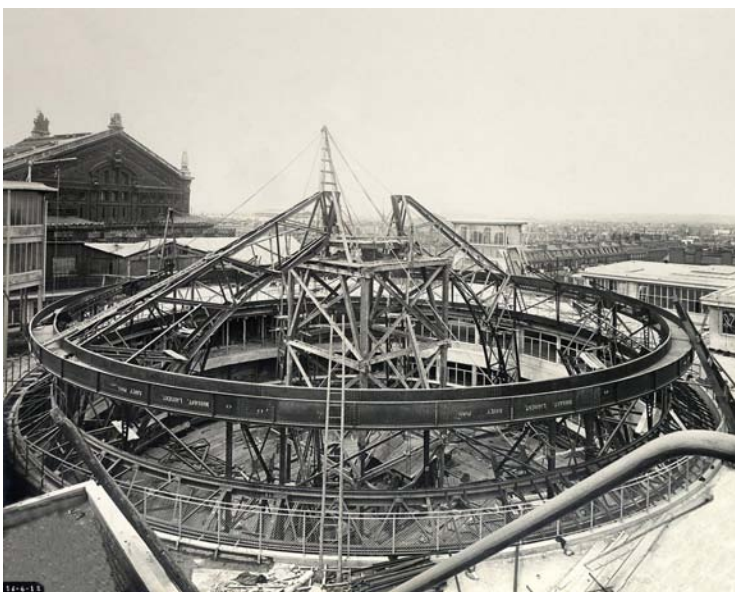
Imagen 3.38 CONSTRUCCIÓN DE LA ESTRUCTURA DEL TRAGALUZ DE GALERIES LAFAYETTE A PRINCIPIOS DEL SIGLO XX
