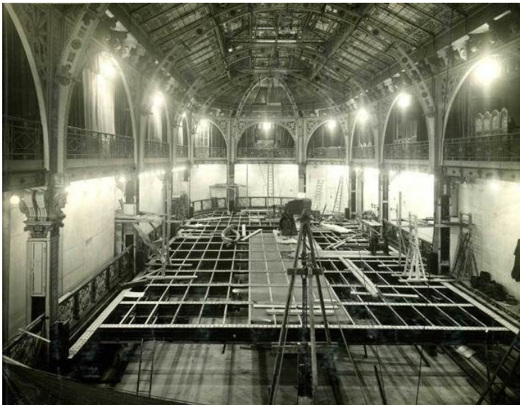
Imagen 3.37 CONSTRUCCIÓN DEL TRAGALUZ EN AU PRINTEMPS A FINALES DEL SIGLO XIX
