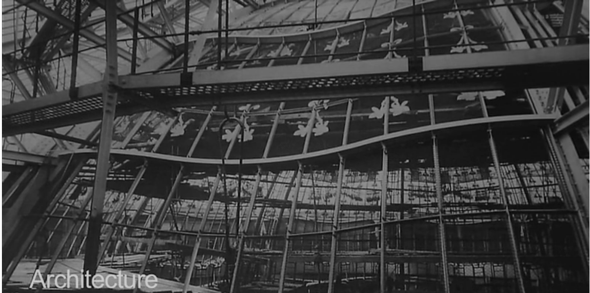
Imagen 3.39 CONSTRUCCIÓN DE LOS DETALLES DEL TRAGALUZ DE GALERIES LAFAYETTE A PRINCIPIOS DEL SIGLO XX
