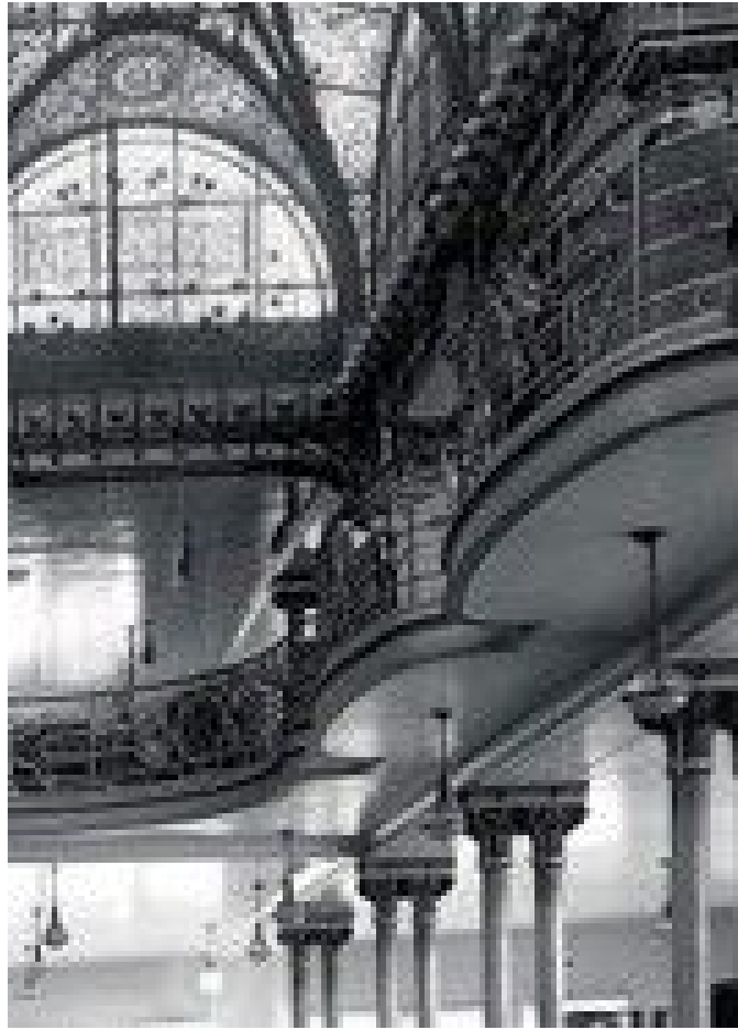
Imagen 3.25 DETALLE DE ENTREPISO EN EL CENTRO MERCANTIL 1930
