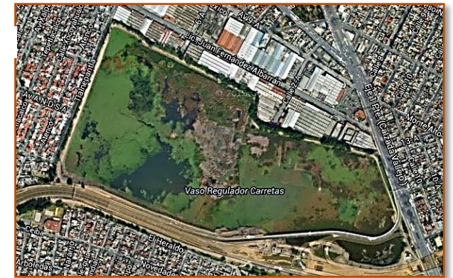
Vaso Reaulador CARRETAS – Autopista Naucalban -Ecatepec
