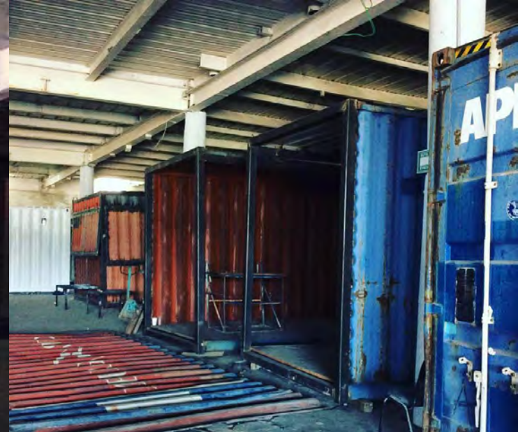
Habilitado de contenedores. Perforación de vanos y colocación de estructura para reforzar. Fotografía personal.
