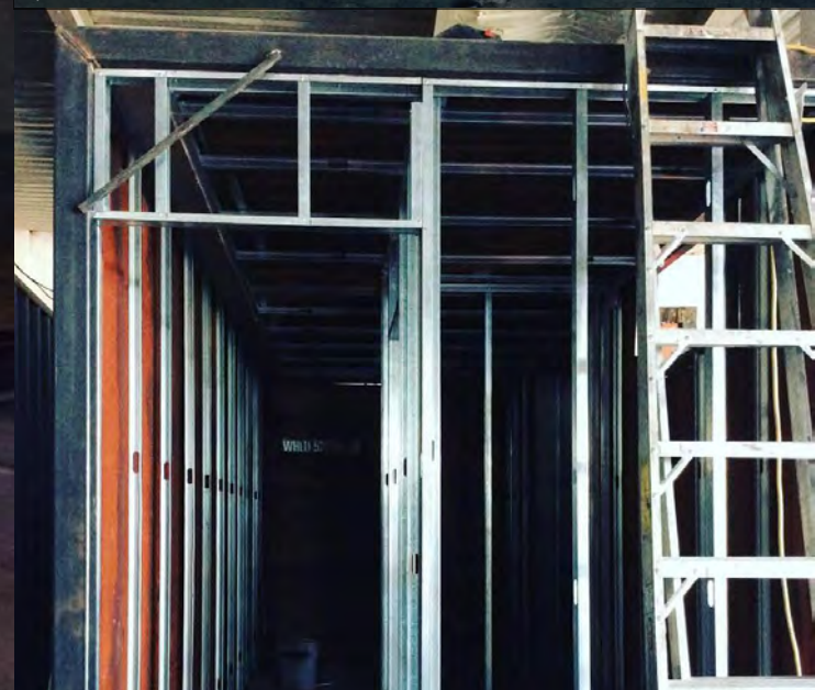
Estructura interior para muros y falsos plafones. Fotografía personal.
