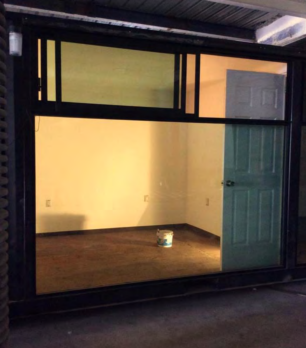
Resultado final: cancelería, acabados, iluminación y revestimientos. Fotografía personal.
