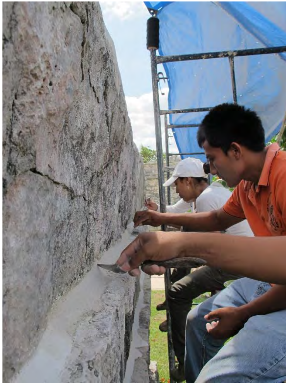
Figura 47. Detalle de manufactura del bisel sobre la moldura superior del primer nivel en la fachada norte. R. Magdaleno, 2014.
