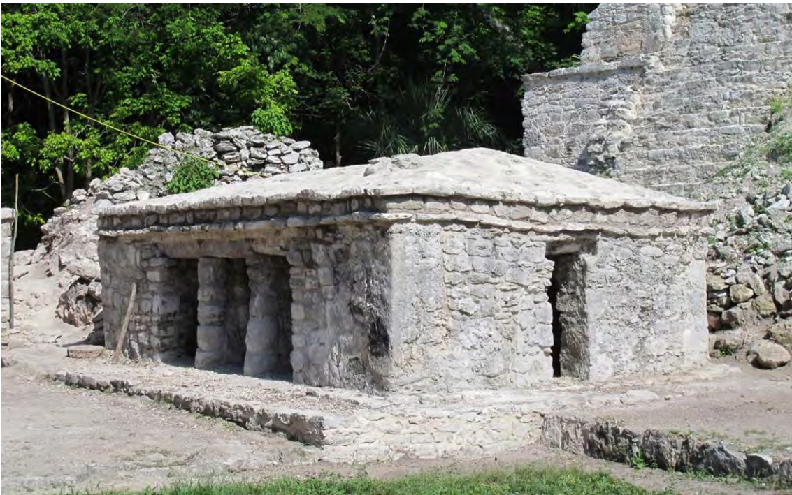
Figura 126. Estructura 7H-3 después de la reconstrucción de la bóveda y el retiro de la palapa de protección por el proyecto de la DEA-INAH. Nótese que la azotea resultó una cubierta a cuatro aguas, rompiendo con toda estética de la arquitectura maya de la región Costa Oriental. Foto R. Magdaleno, 2015.
