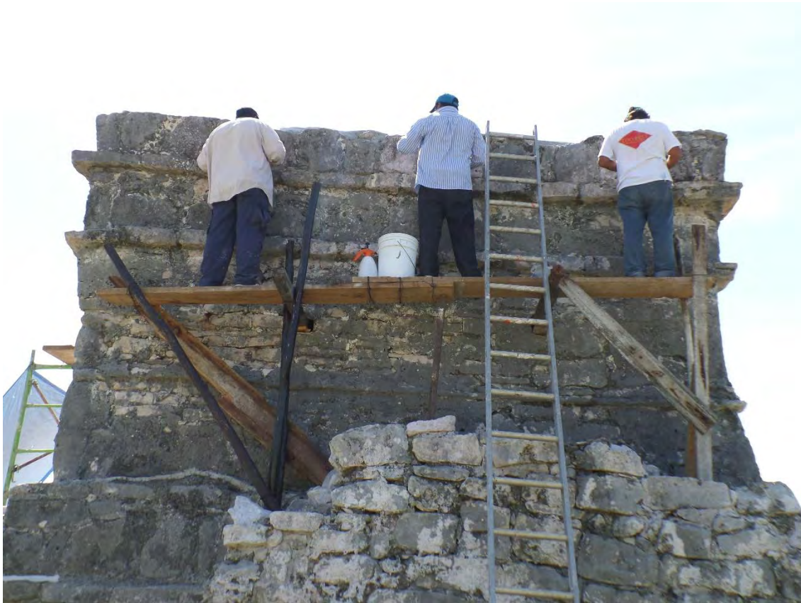
Figura 48. Andamio para la manufactura de biseles en las molduras de la fachada oriente del Templo Superior, Edificio 16. R. Magdaleno, 2014.
