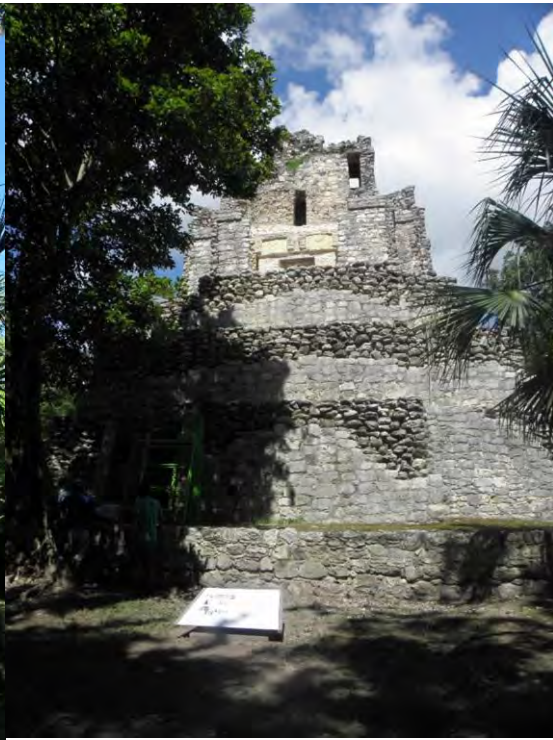
Figura 137. Fachada oriente de El Castillo, concluidos los trabajos de re-enterramiento y el retiro de la cubierta, nótese la recuperación de los volúmenes arquitectónicos y la visual que se tiene de la sub-estructura; fue colocada una cédula informativa al pie del edificio (abajo en la imagen) para explicar al visitante todo el proceso de restauración y re-enterramiento. R. Magdaleno, 2015.
