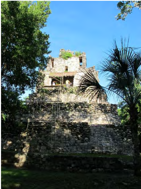
Figura 136. Fachada oriente de El Castillo, previo a los trabajos de re-enterramiento y retiro de la cubierta. Imagen PMQR, 2013.
