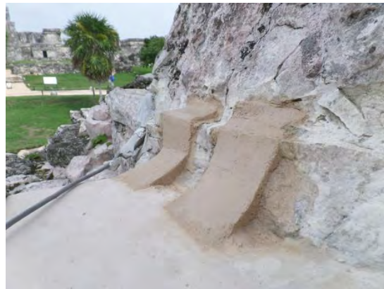
Figura 49. Detalle de las propuestas de los biseles, el de la izquierda en la imagen es el bisel 1 y el de la derecha el 2. F. Godos, 2014.
