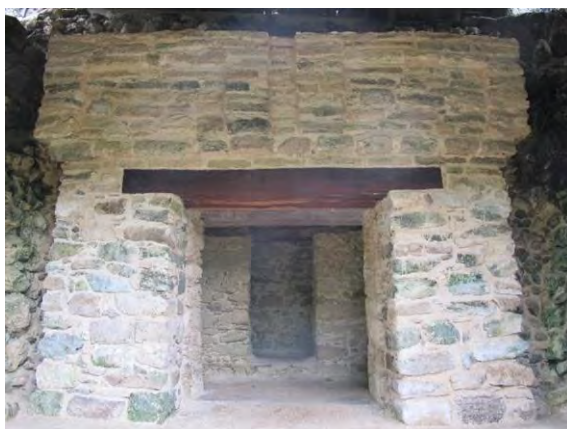
Figura 134. Réplica (caja de re-enterramiento) de la fachada del Templo de la subestructura de El Castillo previa a la colocación de las reproducciones de “Las Garzas”, vista del oriente. Imagen PMQR.
