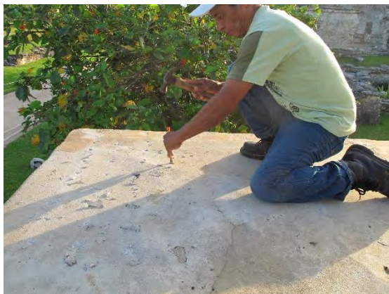
Figura 36. Trabajos de martelinado en la superficie de la terraza en el 2º nivel del Edificio 16. R. Magdaleno, 2012.
