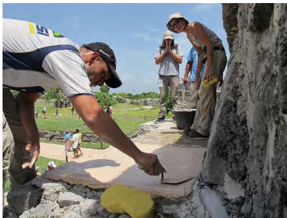
Figura 39. Proceso de colocación de la primera capa con un entortado grueso del piso de sacrificio sobre la terraza del Edificio 16, Tulum. PMQR, 2012.
