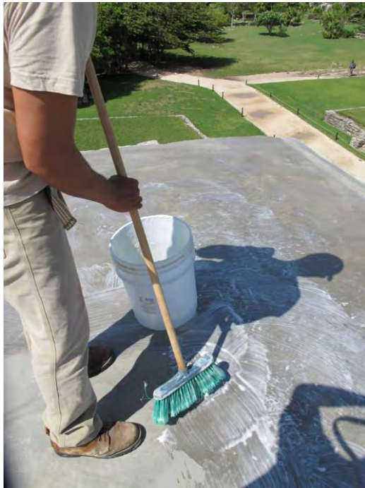
Figura 44. Aplicación del jabón sobre la superficie de la azotea del Edificio 16. Procedimiento de impermeabilización. F. Godos, 2013.
