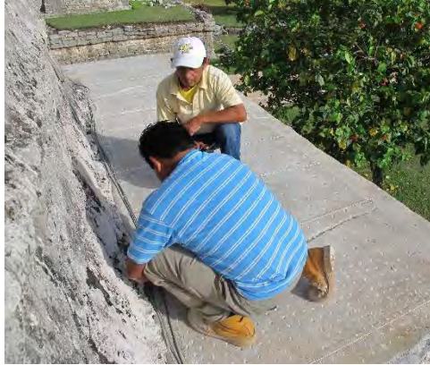
Figura 38. Colocación de hilos – reventones- en la terraza. Edificio 16, Tulum. R. Magdaleno, 2012.
