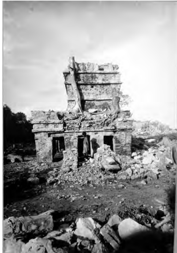
Figura 24. Edificio 16, vista lateral sur; en la imagen se destaca la presencia de dos troncos de árbol cuyas raíces penetraron el núcleo del friso en donde se anclaba la escalinata cuyos restos se localizan en la base del edificio, nótese los escombros y la escala humana. Lothrop, 1924. Tomado del archivo del Peabody Museum , de la Universidad de Harvard.
