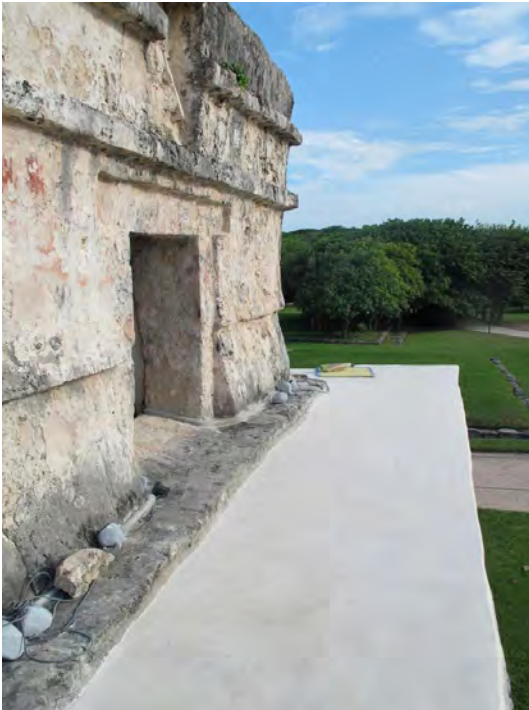
Figura 42. Terraza en su sección poniente, frente a la fachada principal del Templo Superior al concluirse la colocación del piso de sacrificio. Edificio 16, Tulum. R. Magdaleno, 2012.
