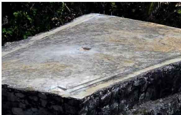
Figura 90. Azotea del Edificio 5 con las calas. Vista del sureste. F. Godos, 2014.
