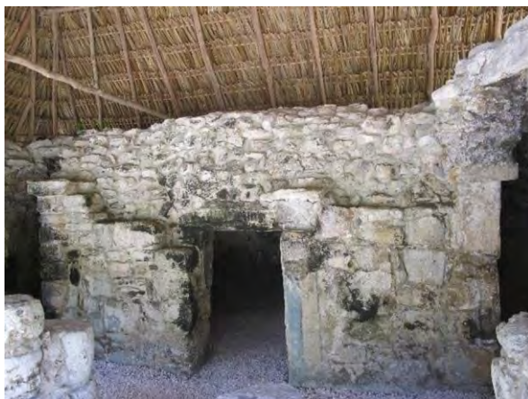
Figura 120. Detalle de la fachada del Santuario Interior de la Estructura 7H-3 de Muyil. R. Magdaleno, 2013.
