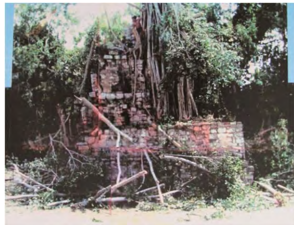
Figura 110. Fachada poniente, Edificio 12. Fotografía de 1998.
