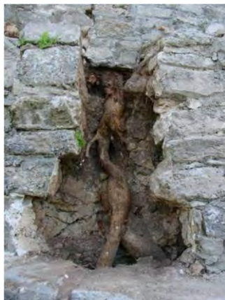
Figura 111. Detalle de la raíz de Kópo localizada en el segundo cuerpo, sección sur, de la fachada poniente de la Estructura 12, fotografía de 2007.
