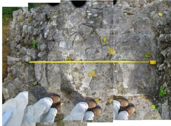
Figura 104. Larguillo de la azotea, Estructura 12. Tanchah. El flexómetro se apoya directamente sobre las tapas de bóveda expuestas. R. Magdaleno, 2012.
