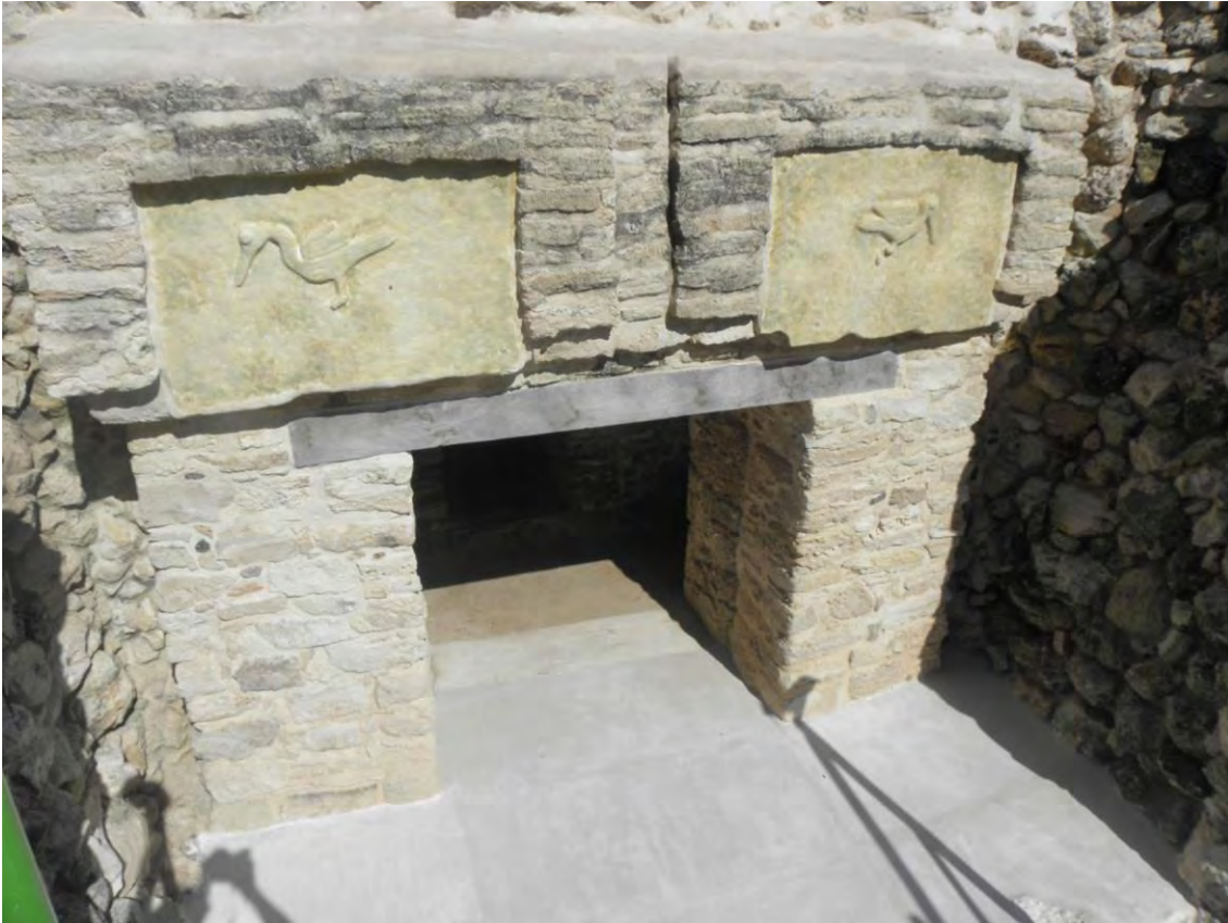
Figura 135. Estado final de la réplica de la fachada del Templo de la subestructura de El Castillo con el proceso final de colocación de la reproducción de los relieves y los aplanados en cubierta y piso de sacrificio. R. Magdaleno, 2015.
