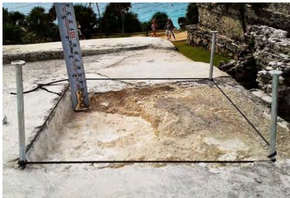
Figura 91. Detalle de la cala de la esquina sureste en la azotea del Edificio 5. Obsérvese a la derecha de la imagen los restos de un aplanado de cal (estuco) que formó parte del enlucido original de la azotea; a la izquierda de la imagen, por debajo del nivel del enlucido un segmento de piedra caliza que forma la base del aplanado. F. Godos, 2017.
