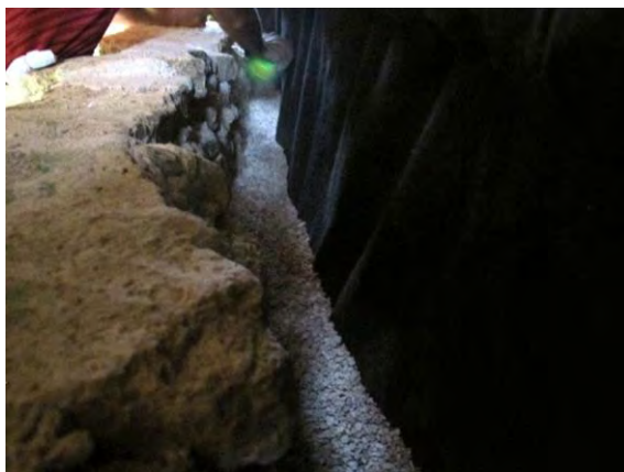
Figura 133. Proceso de relleno con grava entre el geotextil y la mampostería que forma el friso. Imagen PMQR.
