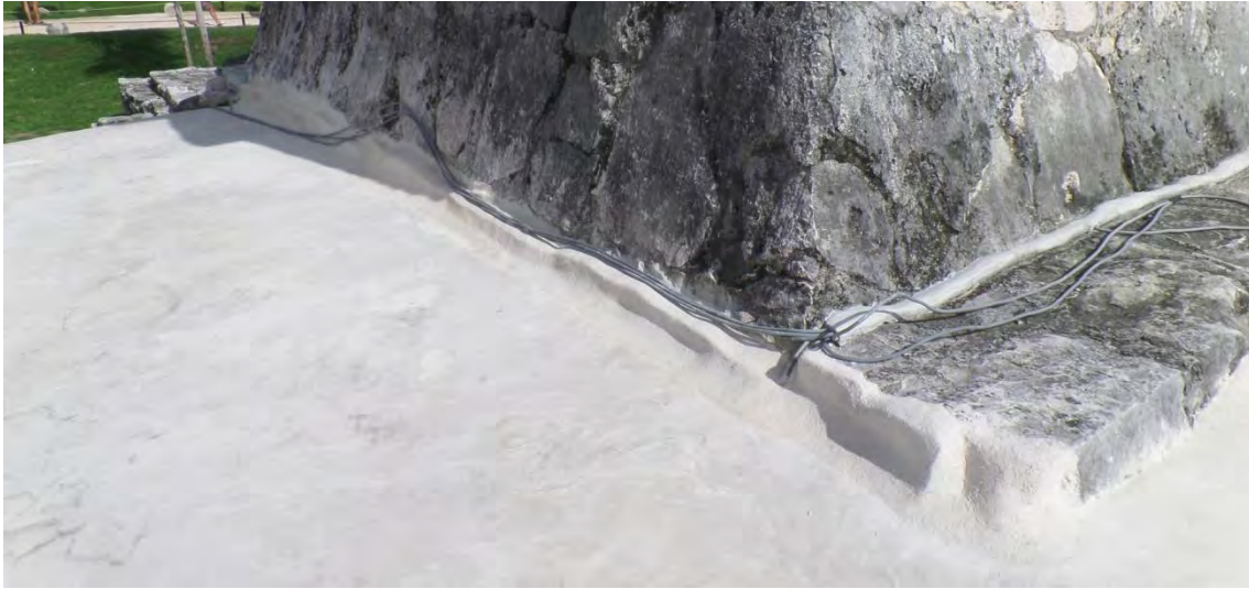
Figura 50. Terraza norte y bisel sobre la plataforma o zócalo del Templo Superior. Edificio 16, Tulum. Vista del noroeste. R. Magdaleno, 2014.
