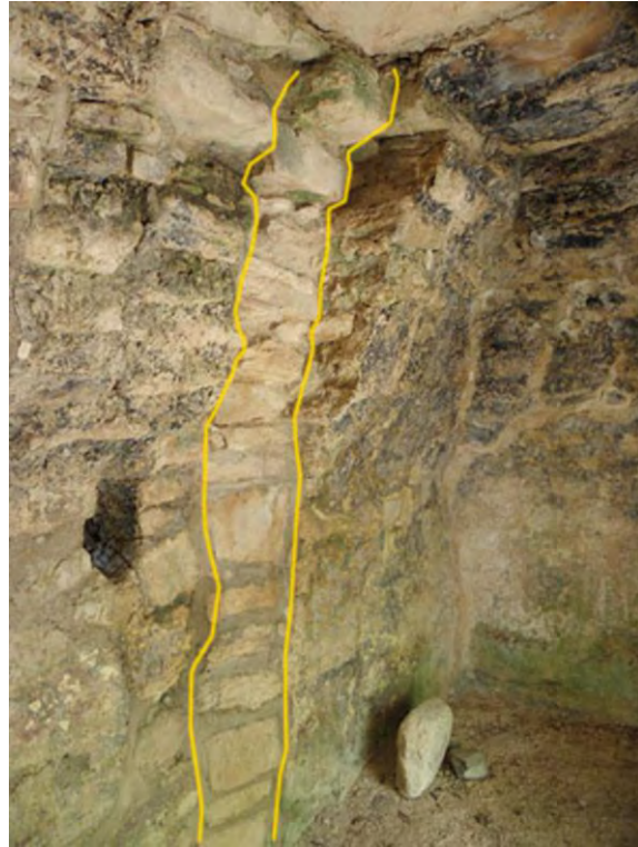
Figura 108. Detalle de la dislocación e intervención sobre la sección central del muro e intradós oeste al interior del templo, Estructura 12, Tancah. R. Magdaleno, 2013.
