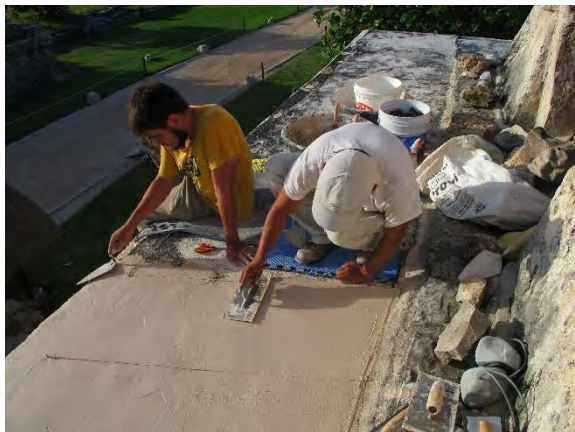
Figura 41. Aplicación de la segunda capa del piso de sacrificio en la terraza del Edificio 16, Tulum. PMQR, 2012.
