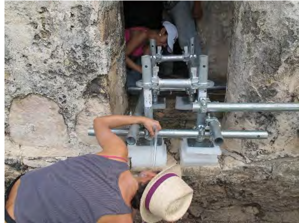
Figura 52. Nivelación de las bases del sistema de apuntalamiento de los dinteles fracturados en el Edificio 16 de Tulum. R. Magdaleno, 2013.
