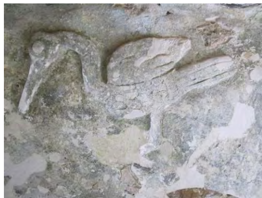
Figura 130. Detalle de la Garza sur posterior a los trabajos de restauración, obsérvese la recuperación de volúmenes y la aplicación de pastas en los aplanados con el criterio de remetimiento para diferenciación de las intervenciones. Imagen PMQR.
