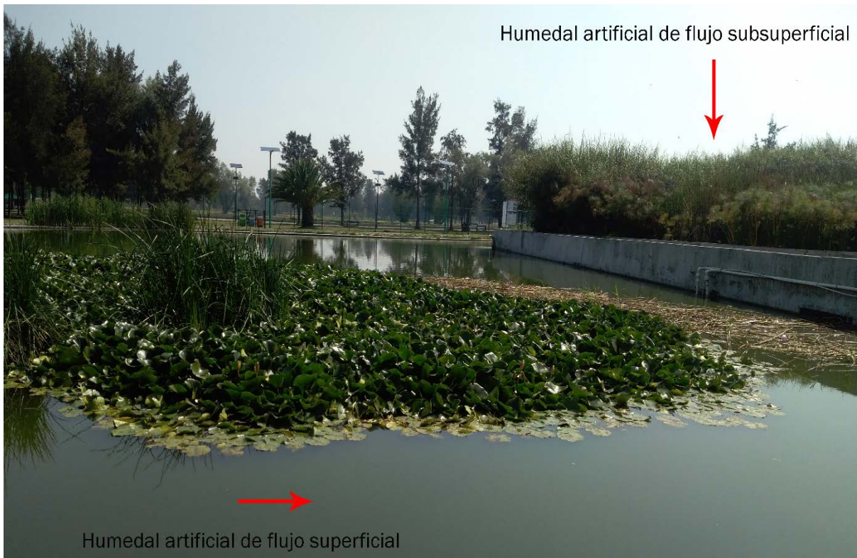
Figura 5-5. Humedal artificial de flujo subsuperficial y Humedal artificial de flujo superficial en el sistema.
