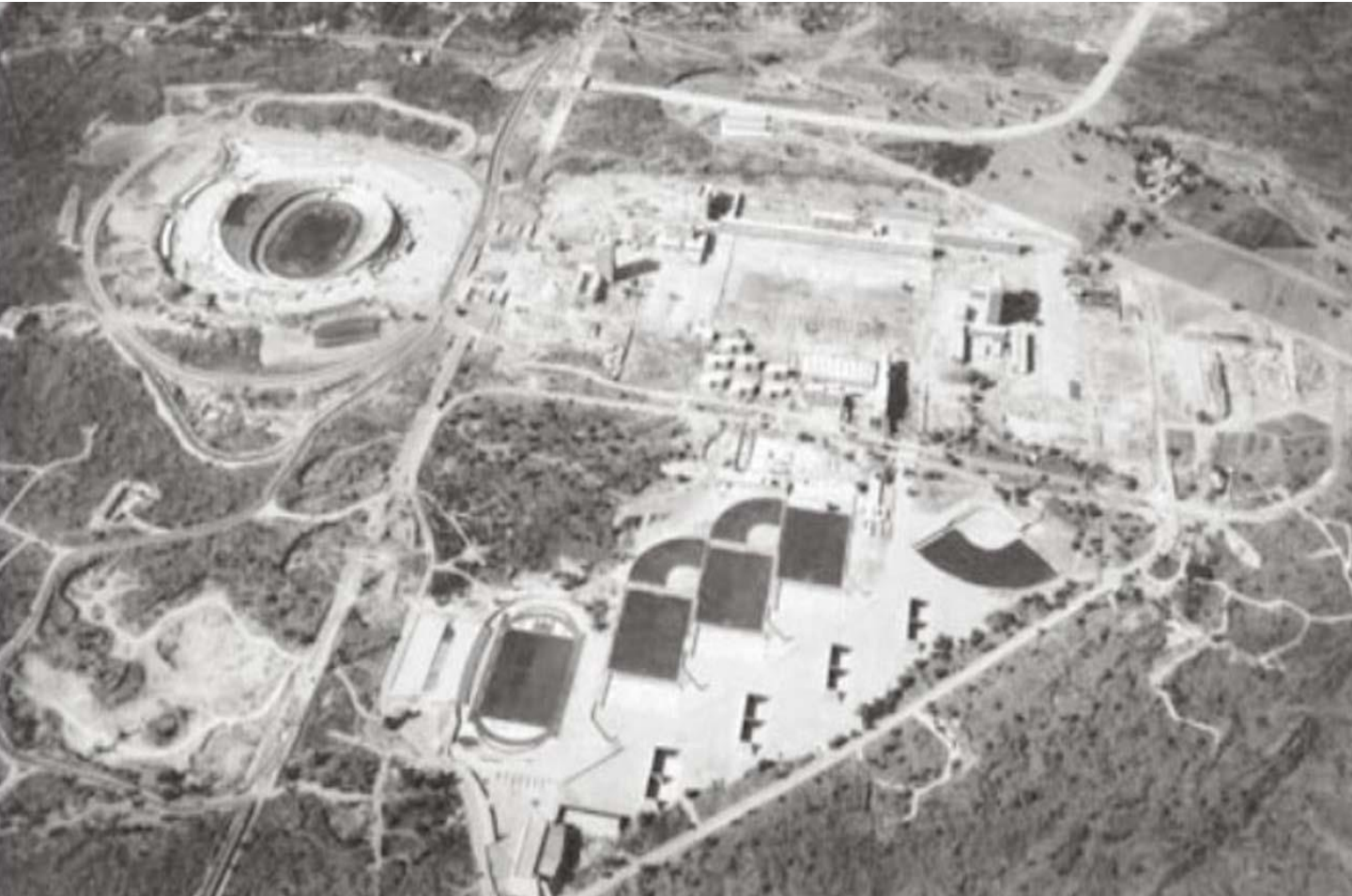
Ciudad Universitaria, vista aérea del inicio de las obras, 1950. 1
