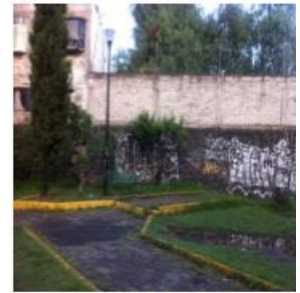
1.Fotografía del Predio
