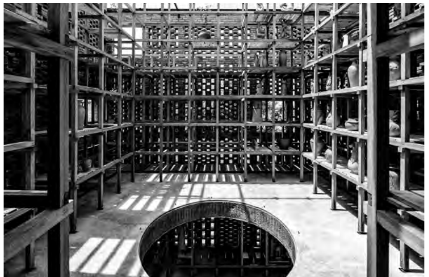
▼ 5.20 Estructura de madera para secado de piezas.
