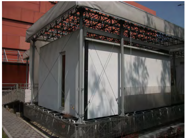
Fig. 84.1 Kitchen: vista exterior suroeste
