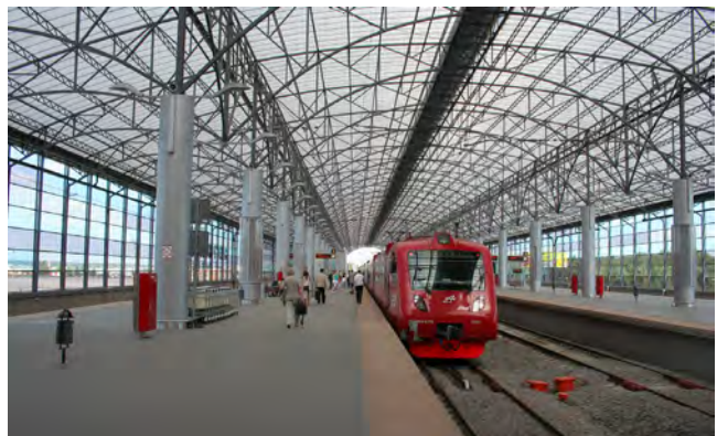
c. Cubierta de Acrílico ("sheremetyevo train station", Moscú)
