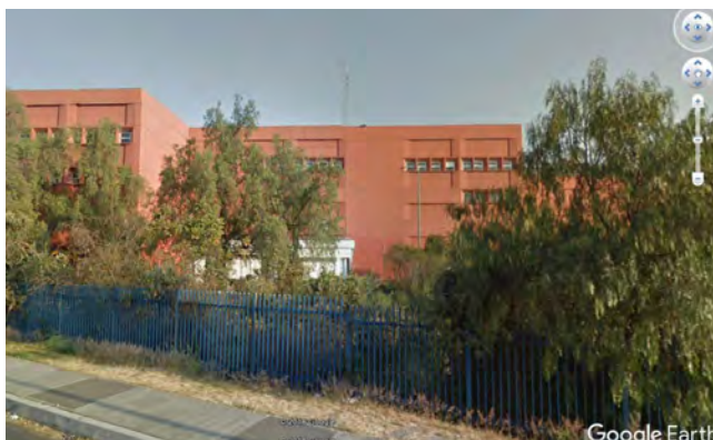
Fig. 93 Vista exterior sur de CASA (desde el circuito)
