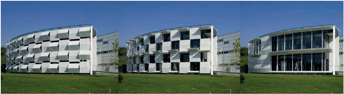
Fig 60 Sistema de sombreado móvil
