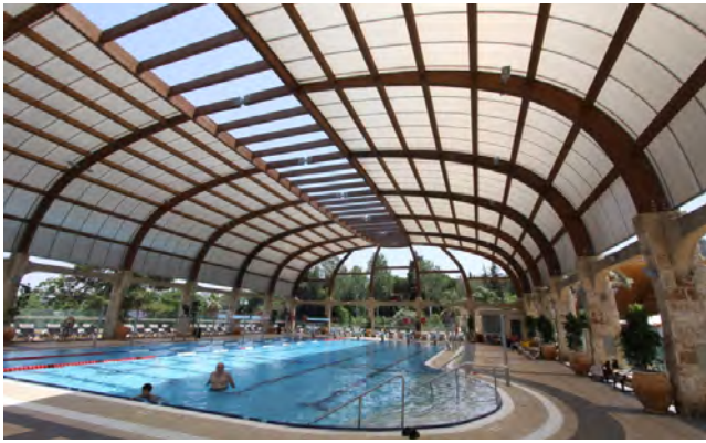
Cubierta de policarbonato ("Technion sport center", Israel)
