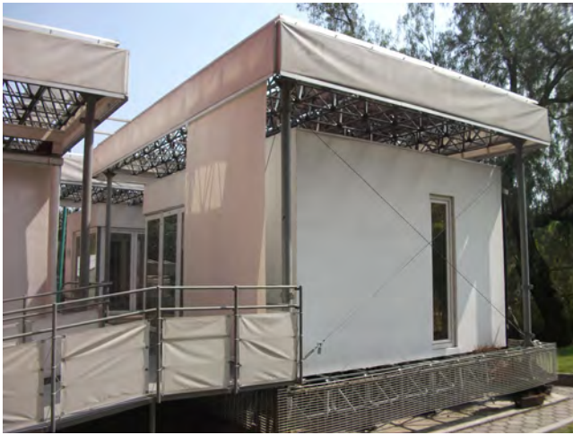
Fig. 84.3 Kitchen: vista exterior noroeste
