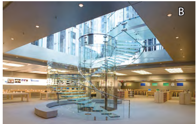
Fig. 67 Aplicaciones de materiales transparentes: Apple Store, N.Y. a) fachada exterior, b) vista interior
