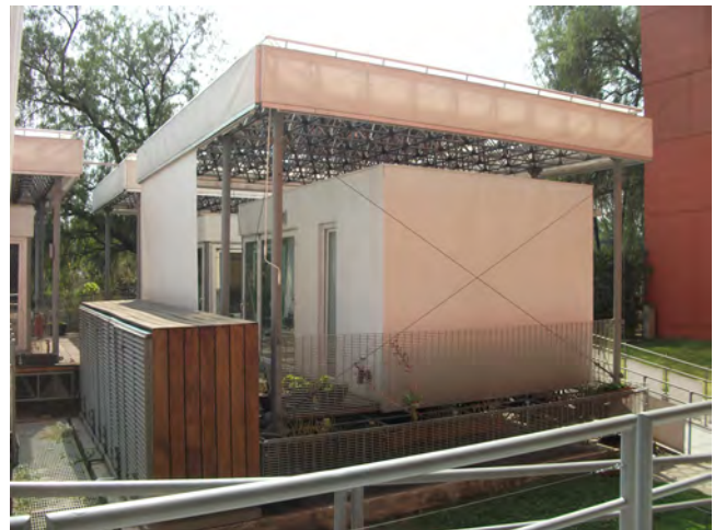
Fig. 83.2 Bedroom: vista exterior noreste
