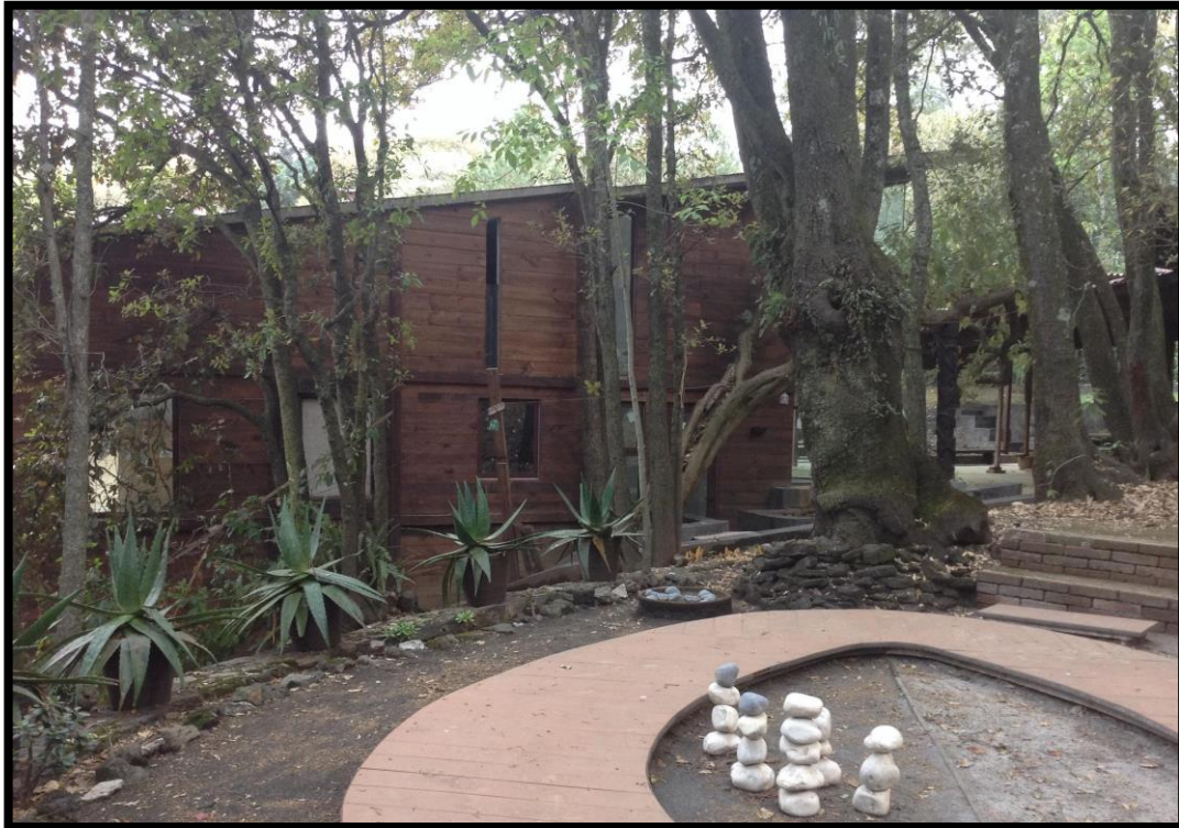
Imagen 3 Fachada norte desde jardín Zen exterior; recubierta en madera de recuperación de la cabaña.
