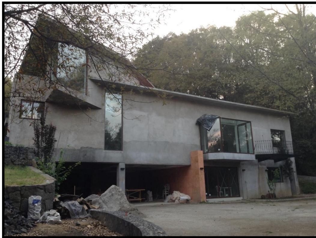
Imagen 6 Fachada noreste, condiciones actuales del inmueble.
