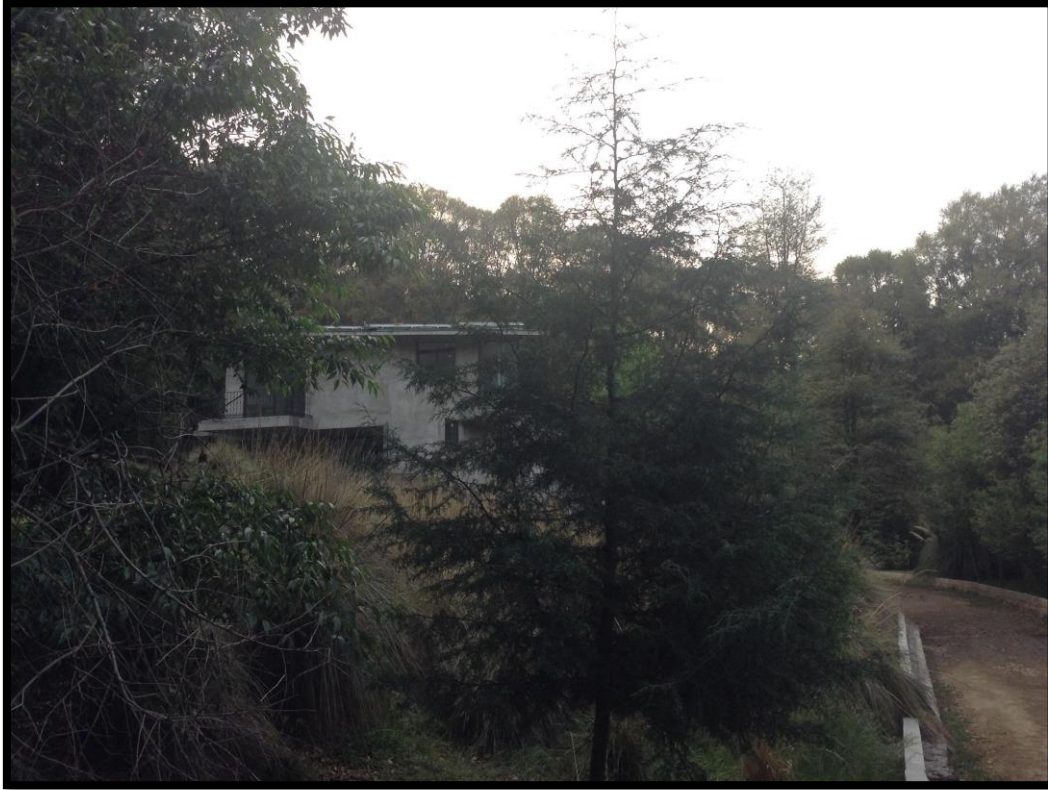
Imagen 9 Vista desde acceso principal, fachada sureste; sobre el techo en la imagen se encuentran instalados los 14 paneles solares.
