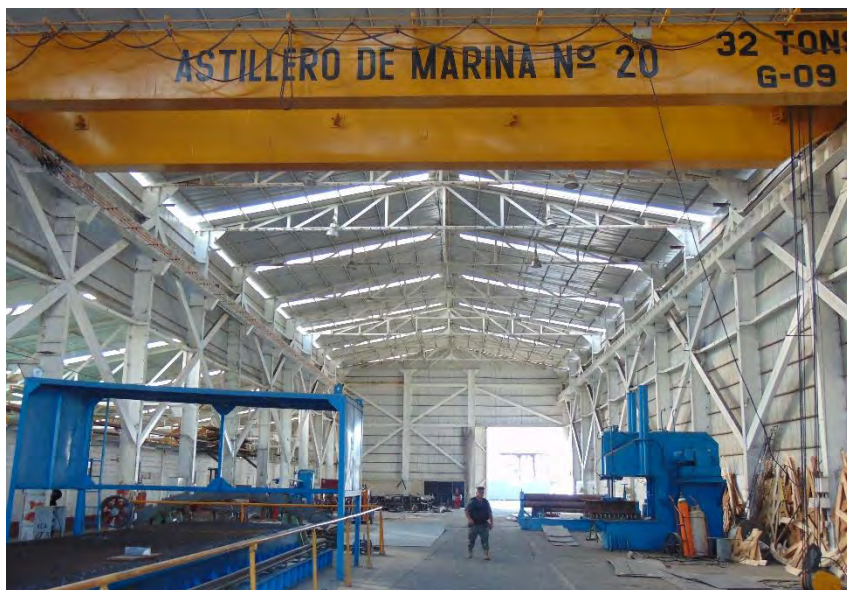
Fig. 79 Vista A taller de pailería y soldadura, ASTIMAR 20, Salina Cruz Oaxaca (126)
