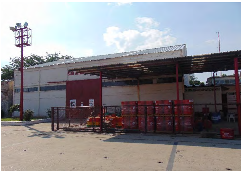
Fig. 86 Área de almacenamiento de combustible, ASTIMAR 20, Salina Cruz Oaxaca (133)
