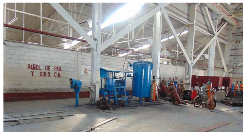
Fig. 80 Vista B taller de pailería y soldadura, ASTIMAR 20, Salina Cruz Oaxaca (127)
