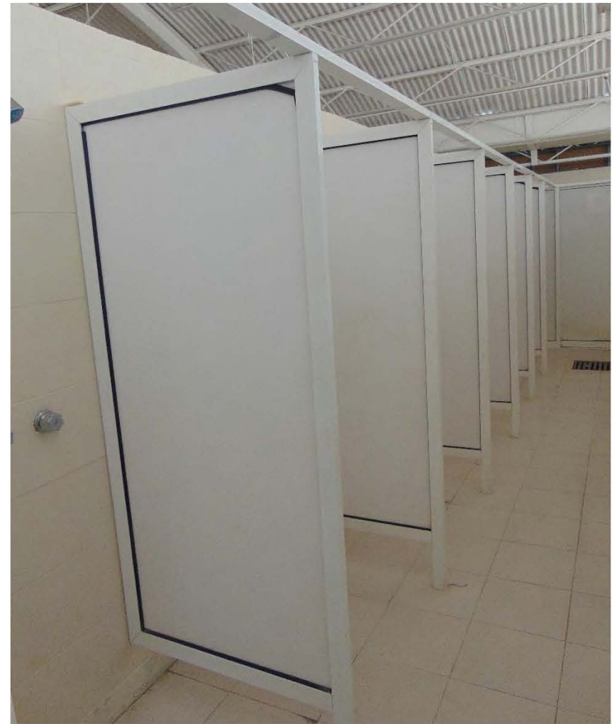
Fig. 101 Área de regaderas, BIM 29 Cuemanco, Xochimilco, CDMX (148)
