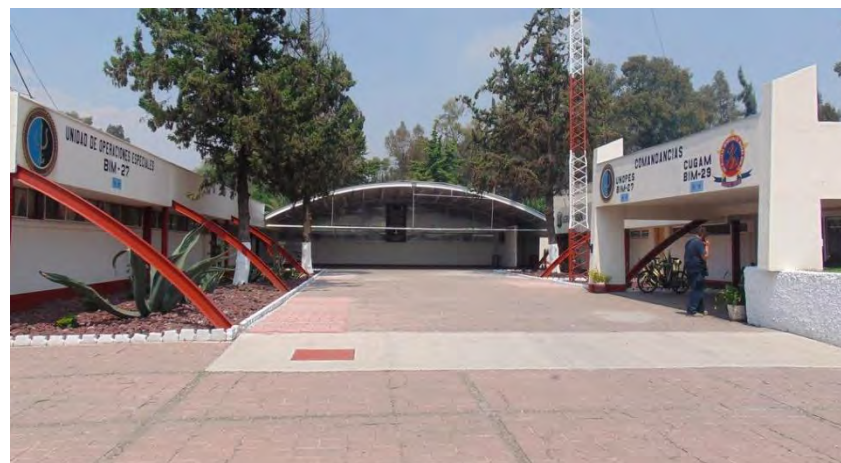
Fig. 95 Vista cuartel general, BIM 29 Cuemanco, Xochimilco, CDMX (142)
