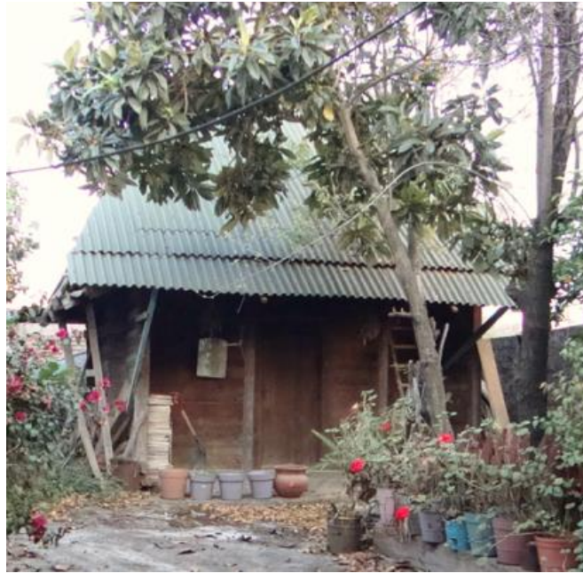
Troje que se conserva con uso de bodega en una vivienda en Cherán. 2012
