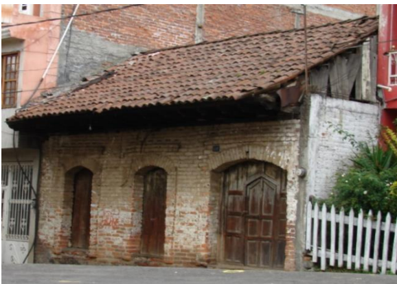
Imagen 24 Vivienda meztiza. Construida con muros de tabique y cubierta de teja. Fotografía: Alexandra Sánchez Soria, Cherán, 2012.
