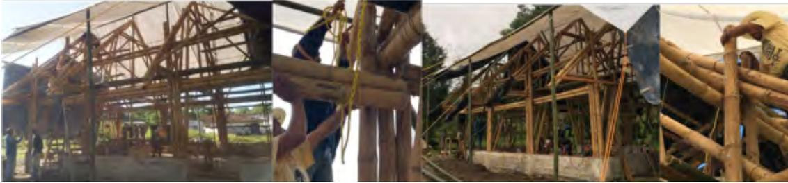
Imagen 114. Rigidización de las armaduras, colocación de riostras longitudinales. Fuente: autor.
