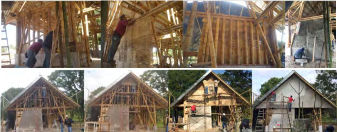
Imagen 122. Estructura de muros, recubrimiento con esterilla y aplanado. Fuente: autor.
