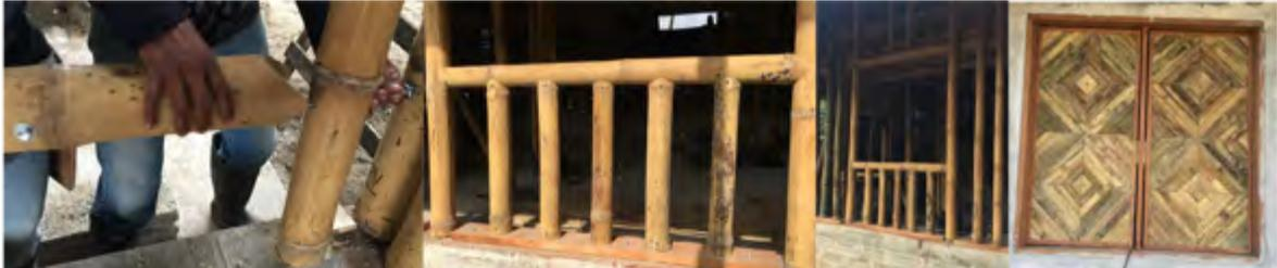
Imagen 127. Armado ventana, fijación a cadena y acabado. Fuente: autor.
