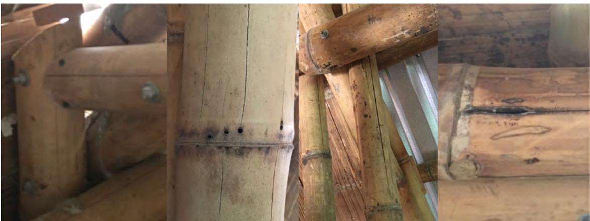
Imagen 141. Estado actual unión de postes verticales con riostras longitudinales y postes diagonales. Fuente: autor
