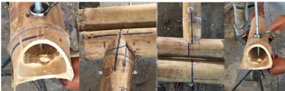
Imagen 108. Unión tensor-cuerdas inferiores. Fuente: autor.
