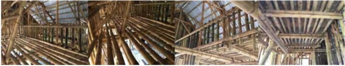
Imagen 116. Estructura de tapanco, unión largueros tensor. Fuente: autor.
