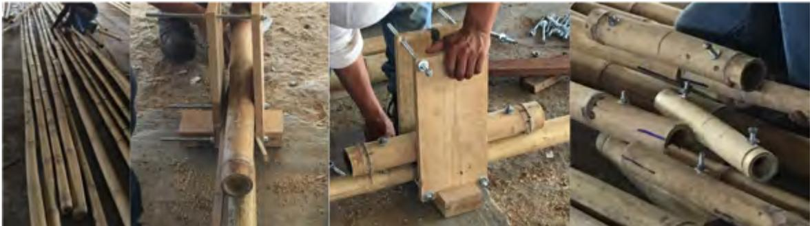
Imagen 110. Unión de elementos de cubierta, sistemas de sujeción. Fuente: autor.
