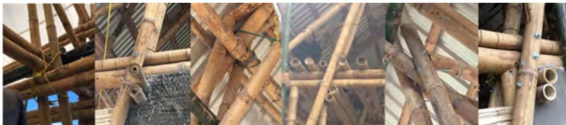
Imagen 119. Uniones de poste diagonal con cuerdas inferiores, riostras longitudinales y cordón opuesto. Fuente: autor.
