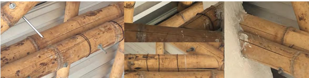
Imagen 140. Estado actual de las uniones entre cuerdas superiores y riostra de cubierta.
