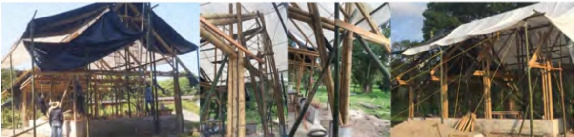
Imagen 113. Colocación de postes verticales y diagonales. Fuente: autor
