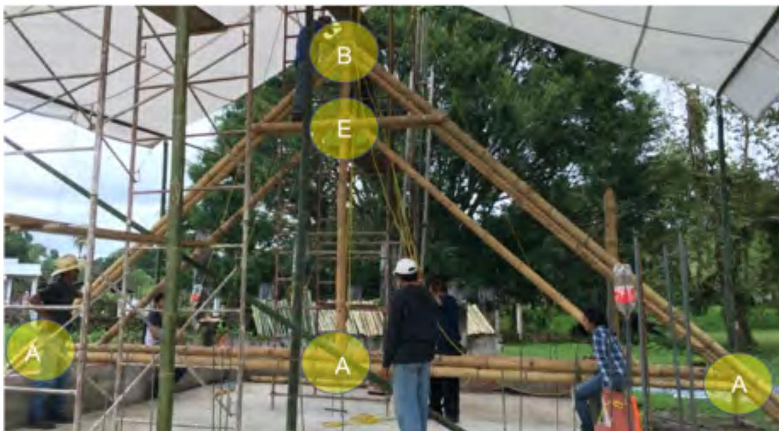
Imagen 104. Armadura, uniones y elementos componentes. Fuente autor.
