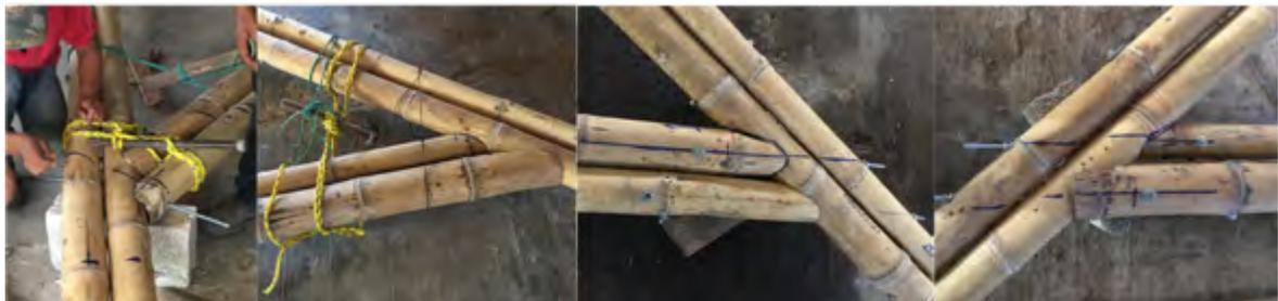
Imagen 106. Amarres provisionales para colocar la varilla roscada en uniones cuerdas superiores- inferiores. Fuente: autor.
