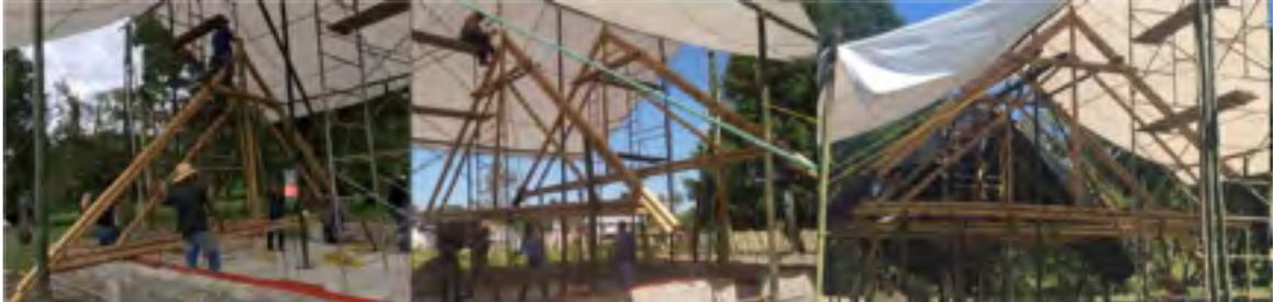
Imagen 112. Proceso de montaje de armaduras. Fuente. autor
