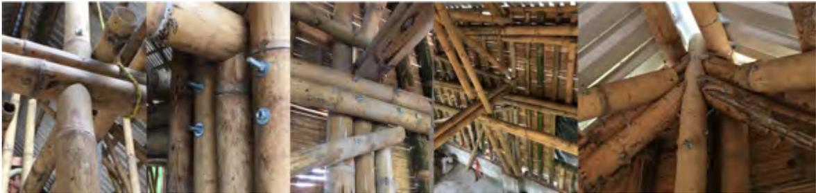
Imagen 120. Unión tensor-cuerdas inferiores-postes verticales, riostra en muros, riostras longitudinales-muros, riostras en cubierta. Fuente: autor.
