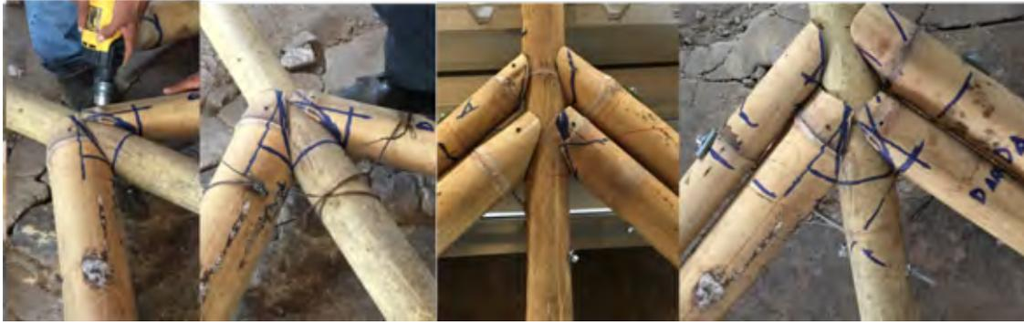
Imagen 107. Unión entre cuerdas superiores y tensor. Fuente: autor.
