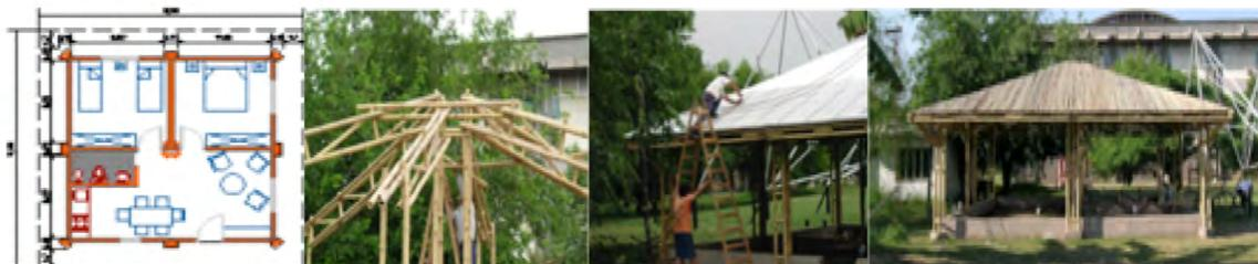
Imagen 17. Funcionamiento, estructura y cubierta prototipo de vivienda. Fuente: (Saleme, 2014).
