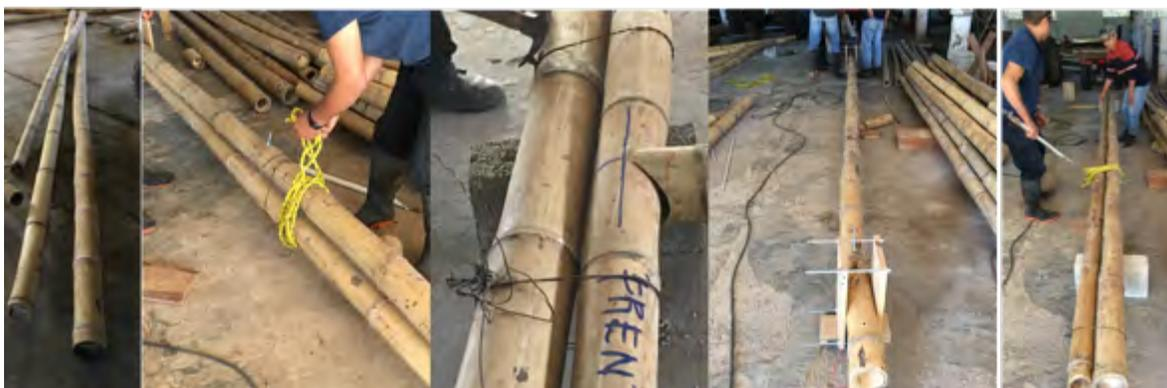
Imagen 102. Amarres provisionales, sujeción de elementos para su fijación con varilla roscada.
