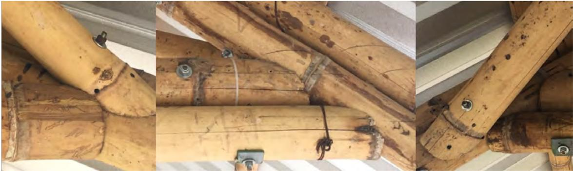
Imagen 139. Estado actual de las uniones entre cuerdas inferiores y riostra de cubierta.
