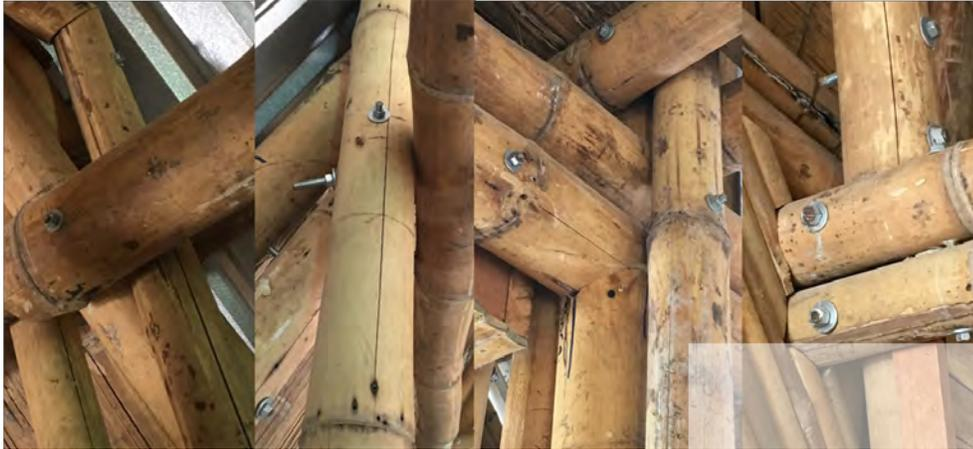
Imagen 142. Estado actual de las uniones entre postes intermedios verticales, riostras longitudinales y postes diagonales. Fuente: autor
