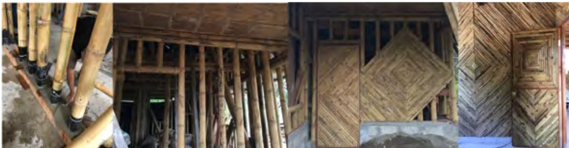
Imagen 123. Acabados muros interiores y acceso. Fuente: autor.
