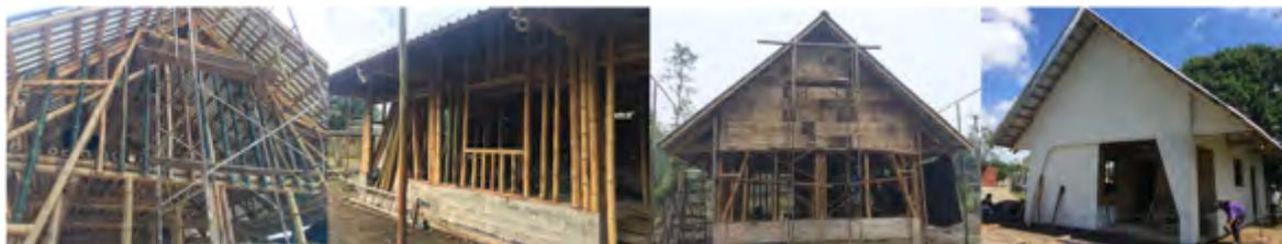
Imagen 129. Proceso constructivo de muros perimetrales. Fuente: autor.
