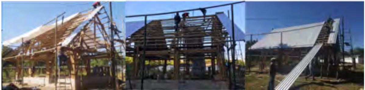
Imagen 117. Instalación de cubierta, con lámina de zinc. Fuente: autor.
