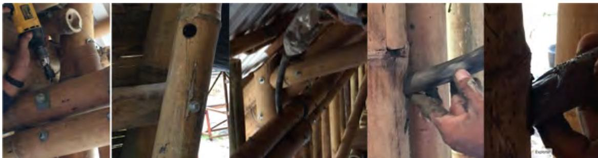
Imagen 121. Perforación, llenado entrenudos con mortero. Fuente: autor.
