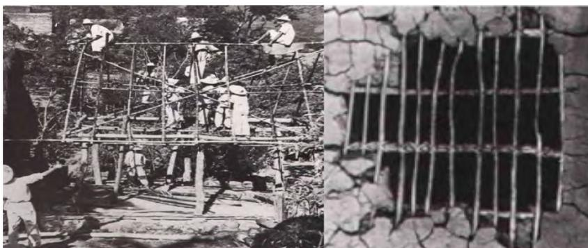
Imagen 20. Estructura de la cubierta con bambú y sistema de bajareque con varas y carrizo.
