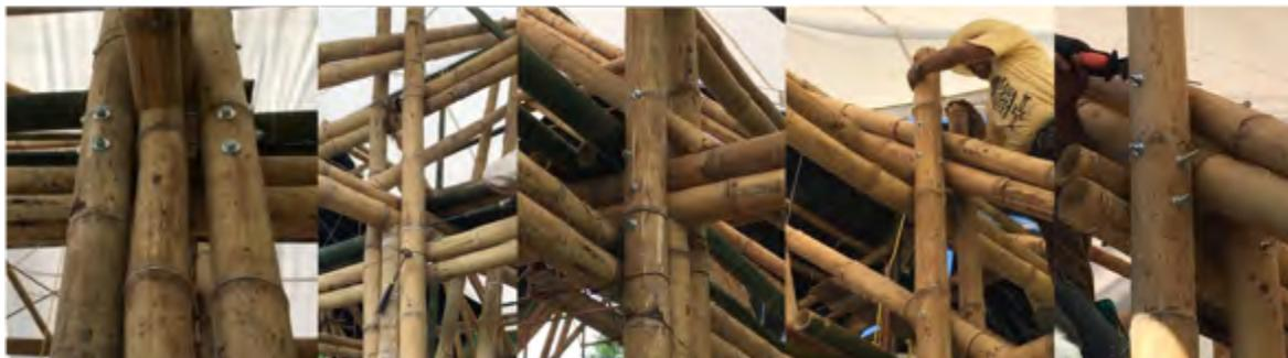
Imagen 118. Uniones poste vertical con cuerdas inferiores, riostras longitudinales y cuerdas superiores. Fuente: autor.
