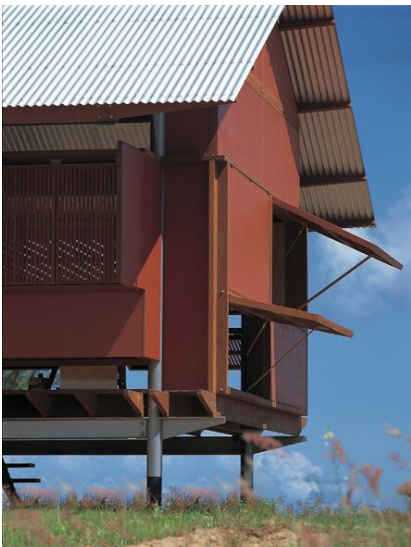
Casa Marika-Alderton por Glenn Murcutt Australia 1994
