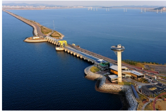
Figura 2.10: Planta mareomotriz Sihwa Lake, 254 MW (flujo y reflujó).
