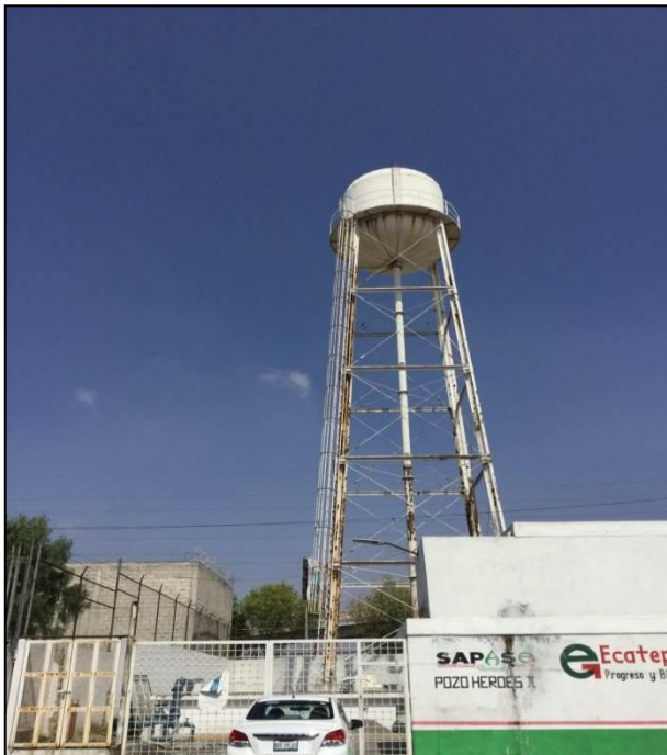
Figura 24 “Pozo que abastece agua de Los Héroes Ecatepec 3ra y 4ta Sección”
