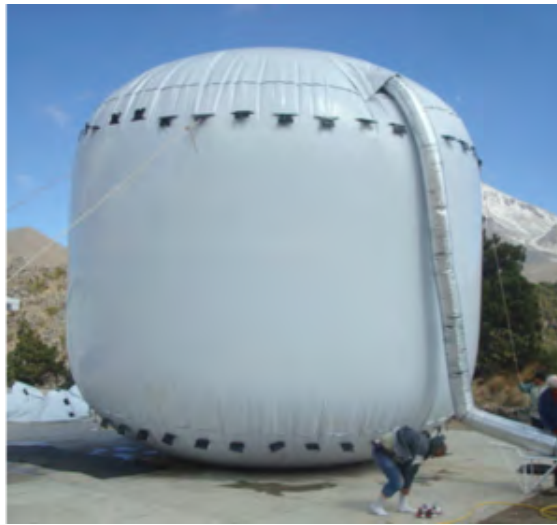
FIGURA 4.4: Bladder: bolsa que se encuentra dentro de los tanques y cuya capacidad es de 200 mil litros de agua ultra-pura.
