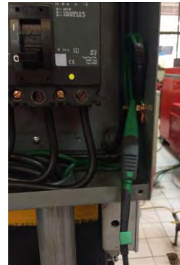
Figura 4. Paso 1-e: conexión a tierra (Ortega & Soladana. 2018).
