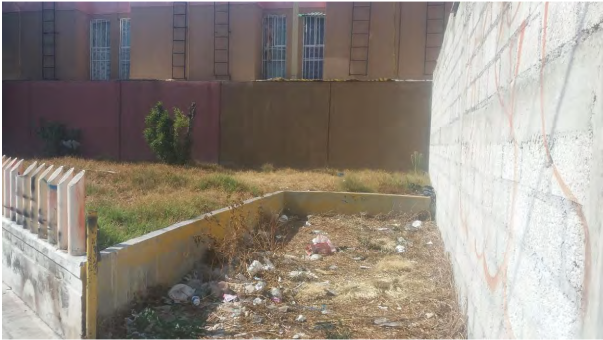
García, G. (2018). Área de uso común descuidada. Los Héroes Tecámac 5 a secc.
