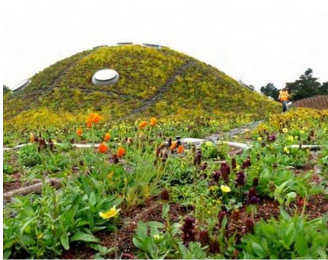
FIGURA 39. Plantas autóctonas en la cubierta son utilizadas como aislante térmico.
