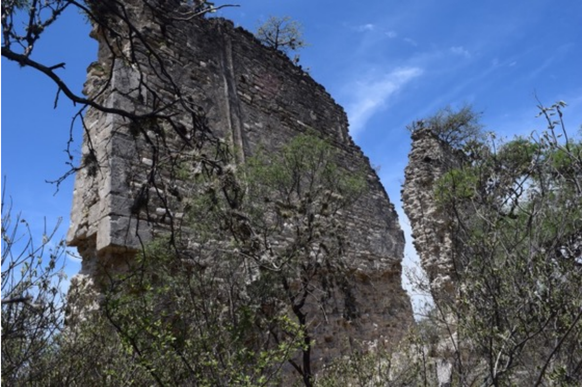
Fig. 9 Retos del muro norte, vista exterior. Foto del autor.
