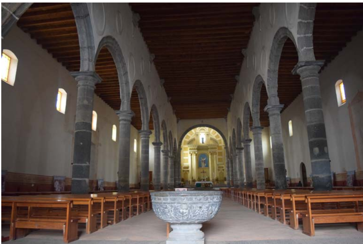
Fig. 65 Interior del templo basilical de San Pedro y San Pablo. Zacatlán. Foto del autor.
