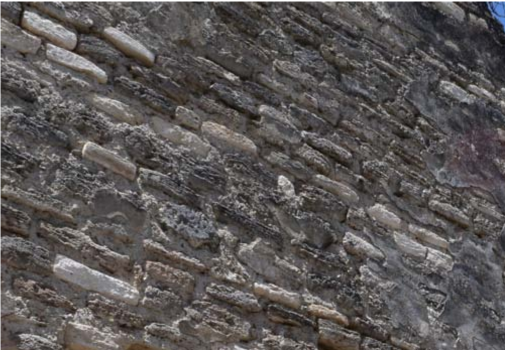
Fig. 16 Mampostería exterior del muro norte del templo, Tehuacán. Foto del autor.
