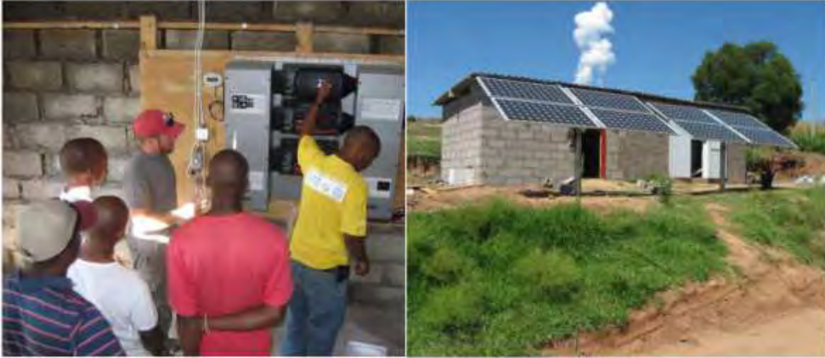
Figura 2.4. Sistema fotovoltaico autónomo en Lesotho
