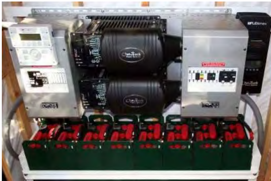
Figura 2.6. Sistema de inversores de baterías en operación
