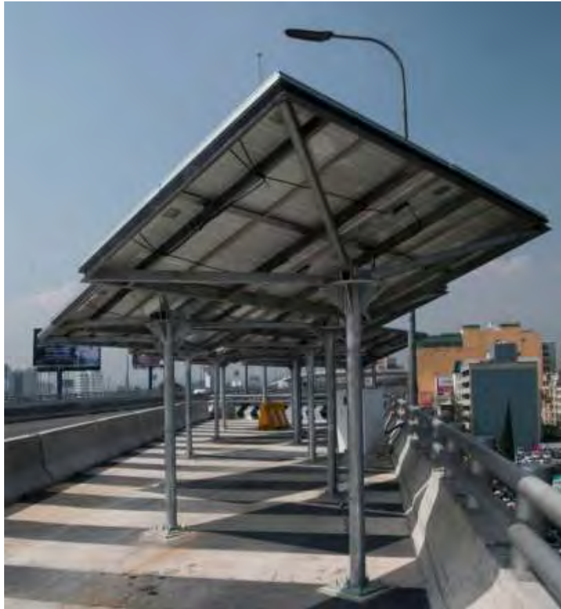
Figura 4.22. Estructuras tipo “árbol solar” de la Autopista Urbana Sur
