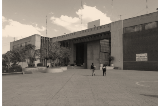
Figura L. Vista de la plaza y acceso desde la calle de Luis Donaldo Colosio. Referencia: Trabajo de campo personal. Pilar López Huidobro 2016.
