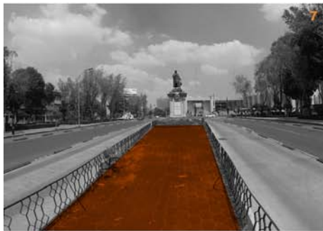
Fotografía 7. Se observa un espacio residual: un camellón que quedó encercado y actualmente los cariles del metrobus lo confinan, sin que los peatones o bicicletas puedan usarlo.
