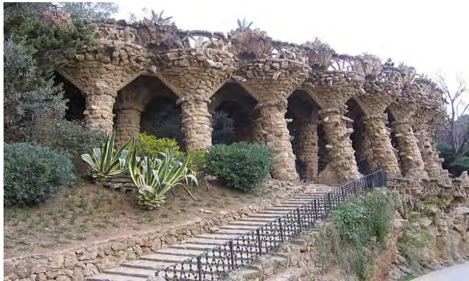
FIG. 24, Viaducto del parque.
