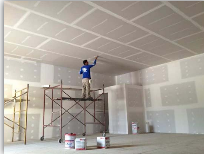
Ilustración 10: Terminado de espacios, con sistema de paneles de yeso.
