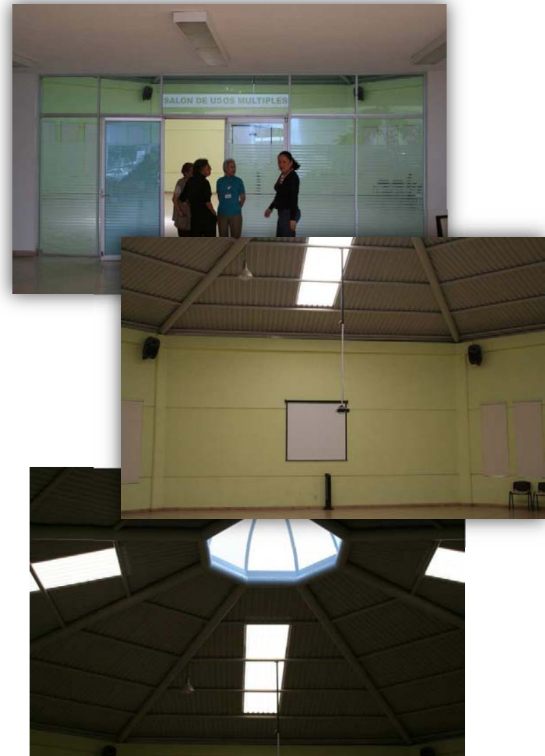
Vestíbulo interior y vista de la cubierta del salón de usos múltiples.
