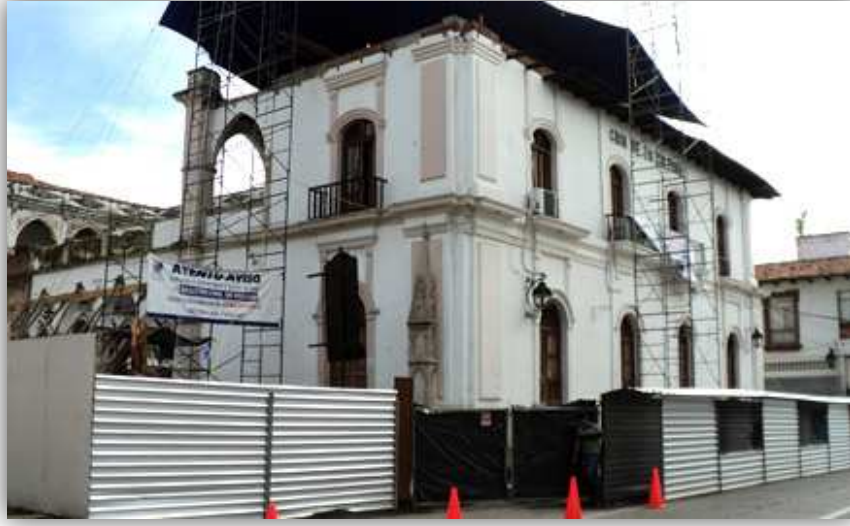
Ilustración 14: Casa de la cultura de la ciudad de Uruapan, durante los trabajos de restauración y que antiguamente fungió como sede del H. Ayuntamiento.
