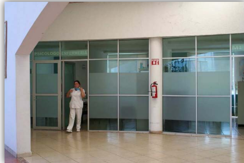
El área médica se encuentra enmarcada por unos grandes pórticos de forma semi circular.
