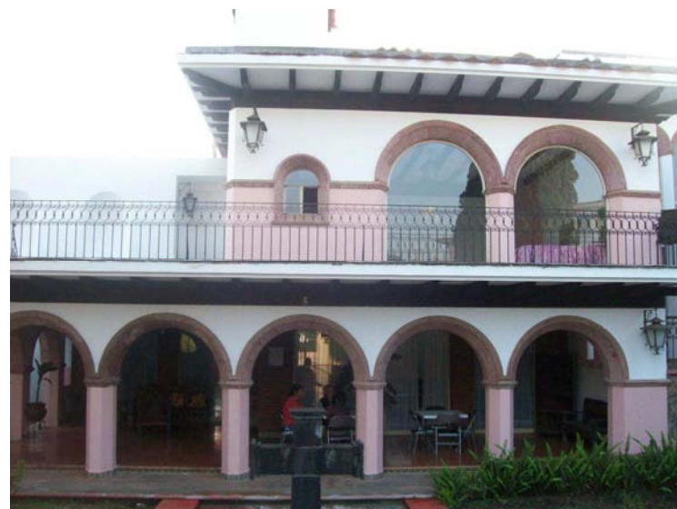
Uso de elementos característicos de la región se hacen presentes en las fachadas exteriores e interiores.
