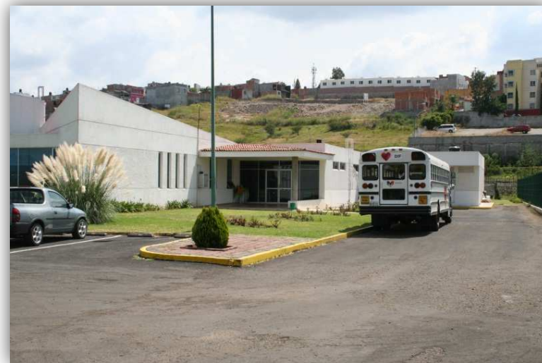
Vista del comedor y patio de maniobras.
