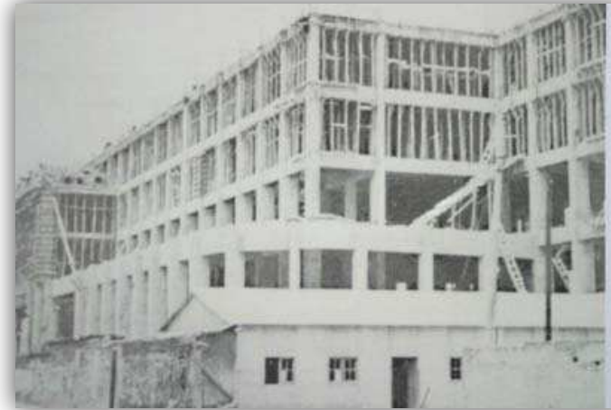
Oficinas generales del I.M.S.S. en reforma, año 1990.
