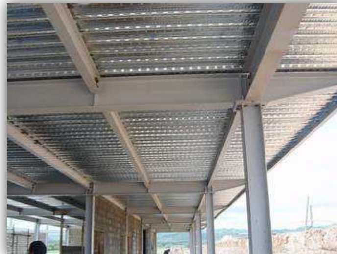
Ilustración 9: Sistema constructivo de losacero, estructura metálica.
