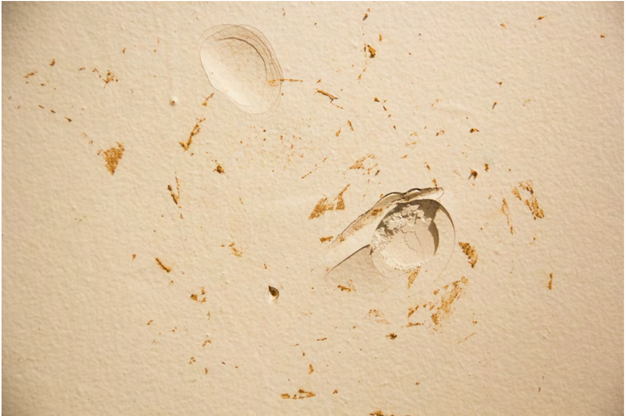
Figura 67 Huellas en los muros del museo donde se ve el impacto de los objetos de barro.
