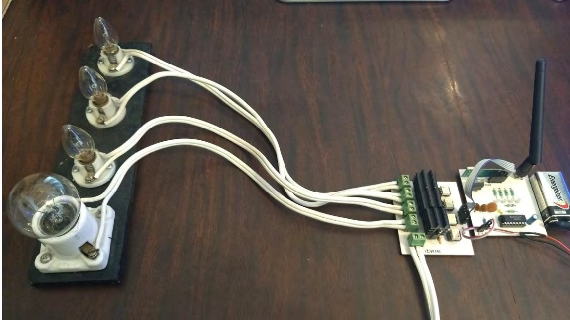
Figura 5.10.- Se muestra la conexión del interruptor controlado por los bits recibidos a través de la tarjeta Rx.
