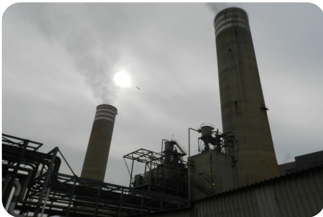
FIGURA 08. Central termoeléctrica "Presidente Plutarco Elías Calles, Chimeneas, 2016. Fuente: Colección propia
