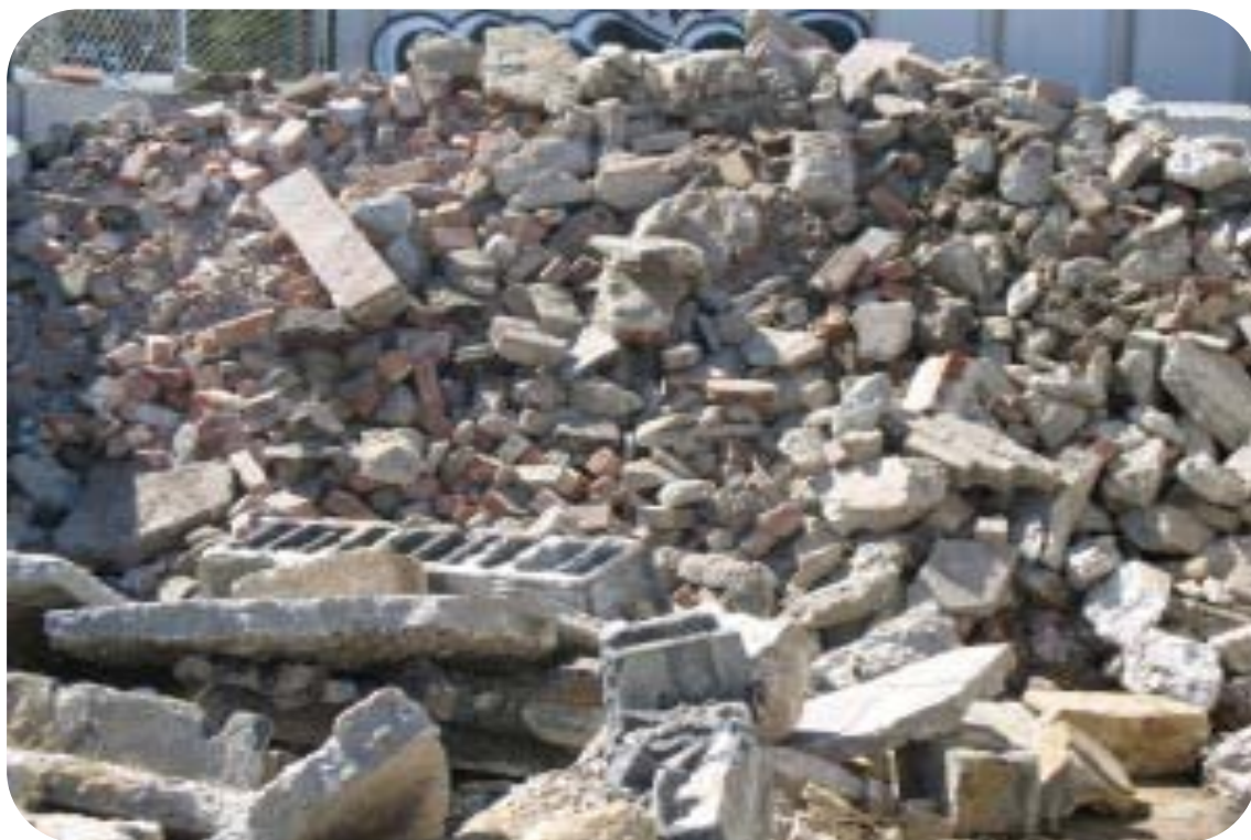
FIGURA 04. Residuos de la demolición de un edificio arquitectónico, 2016. Fuente: < http://bit.ly/2mYywx9 >
