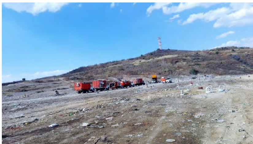
Figura 9 Vista de Celda 3 RS Tlalnepantla (Visita a campo) (1)
