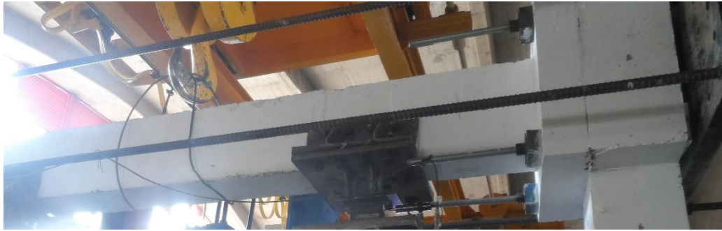
Figura 4.2 Trabe después de las pruebas (sin daños)
