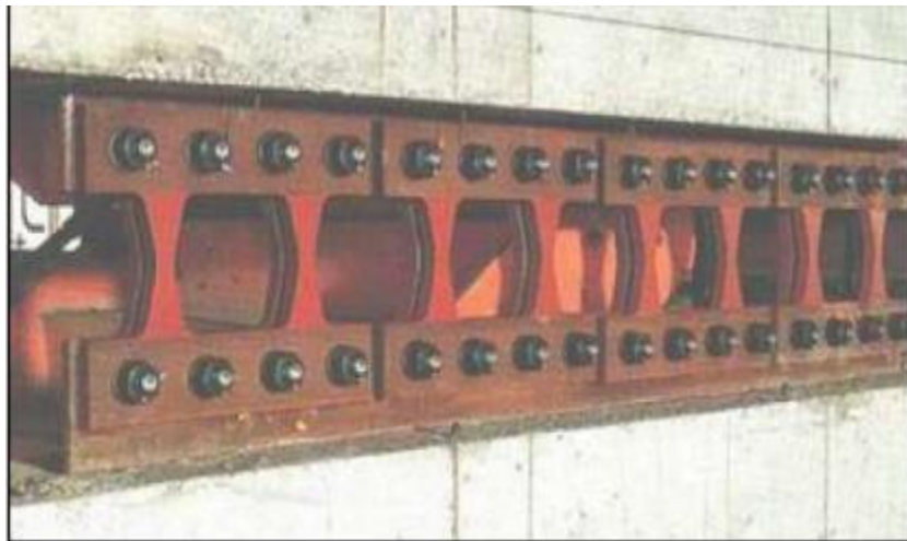
Figura 2.6 Disipador tipo Honeycomb (Gatica, 2012)
