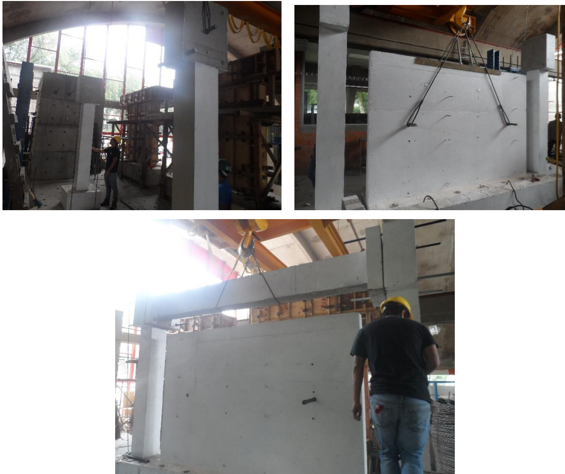
Figura 3.6 Montaje del arreglo marco-muro
