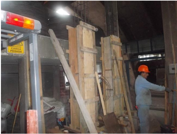
a) Cimbrado de columnas
