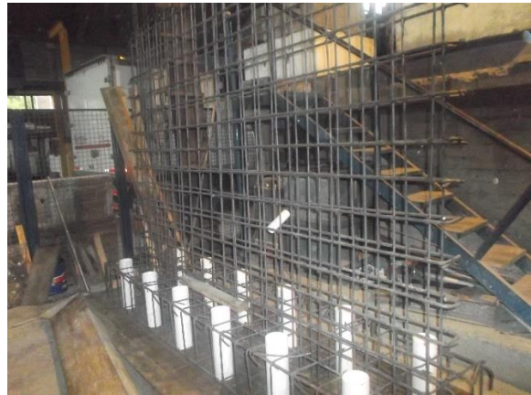
b) Armado de muro
