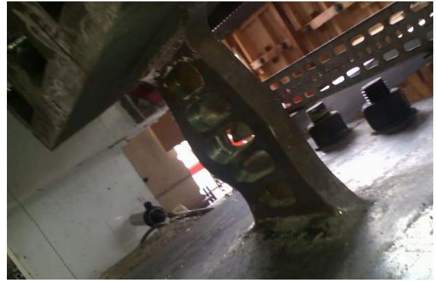
Figura 4.4 Daños en disipadores tipo 1
