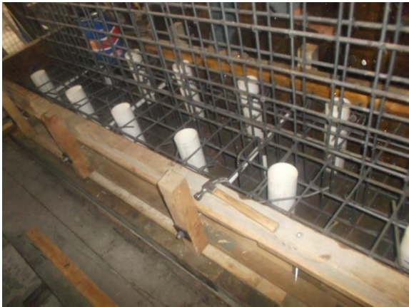
c) Armado de zapara de muro
